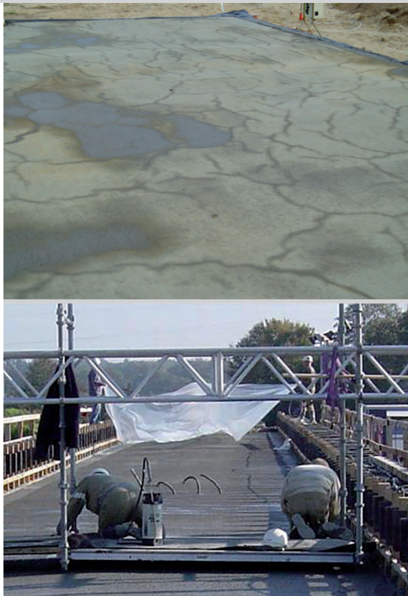
Figur 2.15. Øverst: Plastisk svind som følge af mangelfuld udtørningsbeskyttelse. Nederst: I baggrunden ses indækning med plastik.
