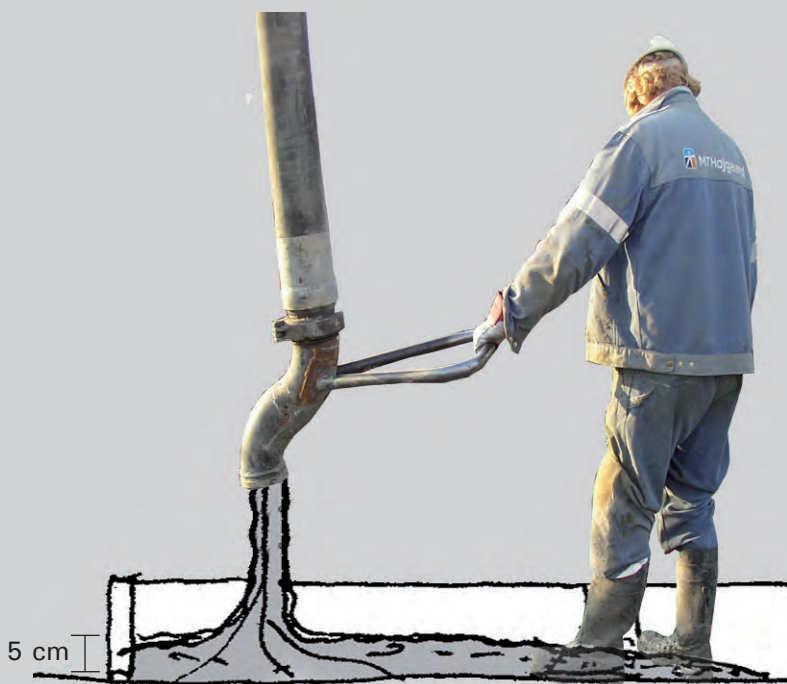
Figur 4.4. Eksempel på gulvstøbning med et højt udbredelsesmål på ca. 675 mm. Dårlig kontrol over støbefronten, som flyder langt. Det er ikke muligt at nå færdig støbehøjde (fx 100 mm) i en arbejdsgang, da betonen vil flyde op imod 4 m væk fra indløbet. Dette er med til at øge risikoen for dynamisk separation markant. Ikke muligt at støbe uden at skulle gå i betonen.
