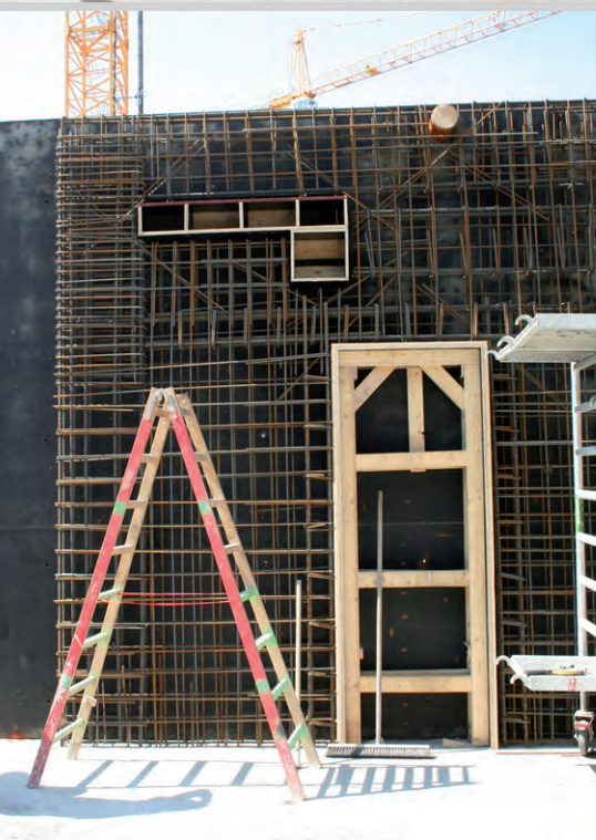
Figur 2.3. Forberedelser af vægform i ca. 4 m højde. Eksempel på udsparinger i vægform. Nederst til højre ses, hvordan den lodrette træstolpe ikke har været afstivet tilstrækkeligt for hydrostatiske støbetryk og bøjer let indad. Risikoen for skader mindskes ved at holde samme støbehøjde på hver side af udsparingen, dvs. formfyldningen foregår skiftevis på hver sin side af udsparingskassen.
