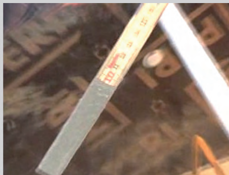
Figur 2.10. Kraftig separation (10 cm uden sten) – Der kan ikke etableres ru støbeskel.
