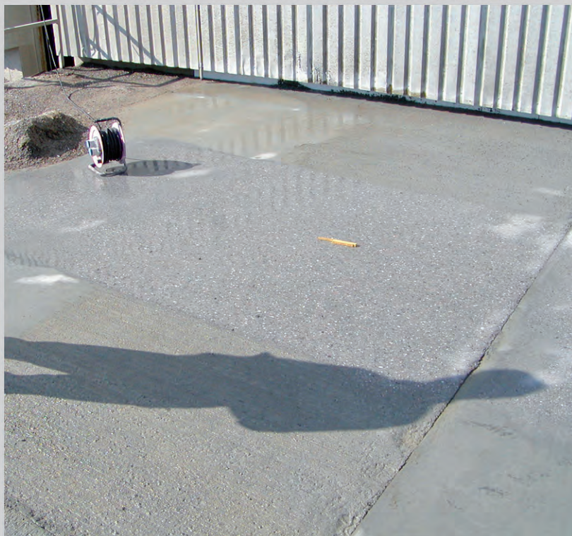
Figur 4.7. Øverst til venstre: SCC gulv glittes. Det er en erfaringssag at vurdere det korrekte glittetidspunkt. Især ved større gulvarealer er det vigtigt at være opmærksom på en ensartet levering til pladsen, da det ellers giver uens overfladekvalitet der vanskeliggør glitning. Øverst til højre: SCC overflade afsluttet med 25 promilles tværfald. Nederst til venstre: Planafrettet (venstre) og juttet (højre) overflade af SCC med lavt flydemål på ca. 480 mm og relativ høj viskositet. Planafretteren trækker tydelige spor efter sten mens jutteren har lidt svært ved at dykke stenene. Nederst til højre: Eksempler på forskellig overflade på det samme gulv – glittet, slebet og kostet.
