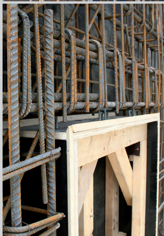
Figur 2.3. Forberedelser af vægform i ca. 4 m højde. Eksempel på udsparinger i vægform. Nederst til højre ses, hvordan den lodrette træstolpe ikke har været afstivet tilstrækkeligt for hydrostatiske støbetryk og bøjer let indad. Risikoen for skader mindskes ved at holde samme støbehøjde på hver side af udsparingen, dvs. formfyldningen foregår skiftevis på hver sin side af udsparingskassen.
