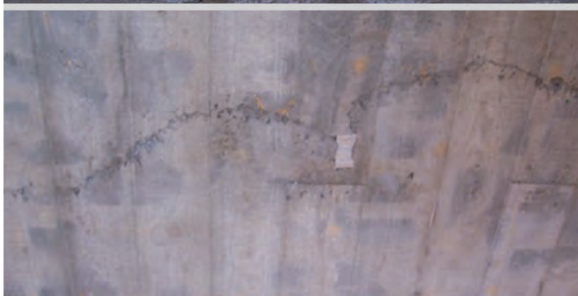
Figur 2.14. Øverst: Afstandsholder i færd med at blive omstøbt af SCC. Nederst og i midten: Synligt fodaftryk fra samme afstandsholder i brædeforskallet dækunderside.
