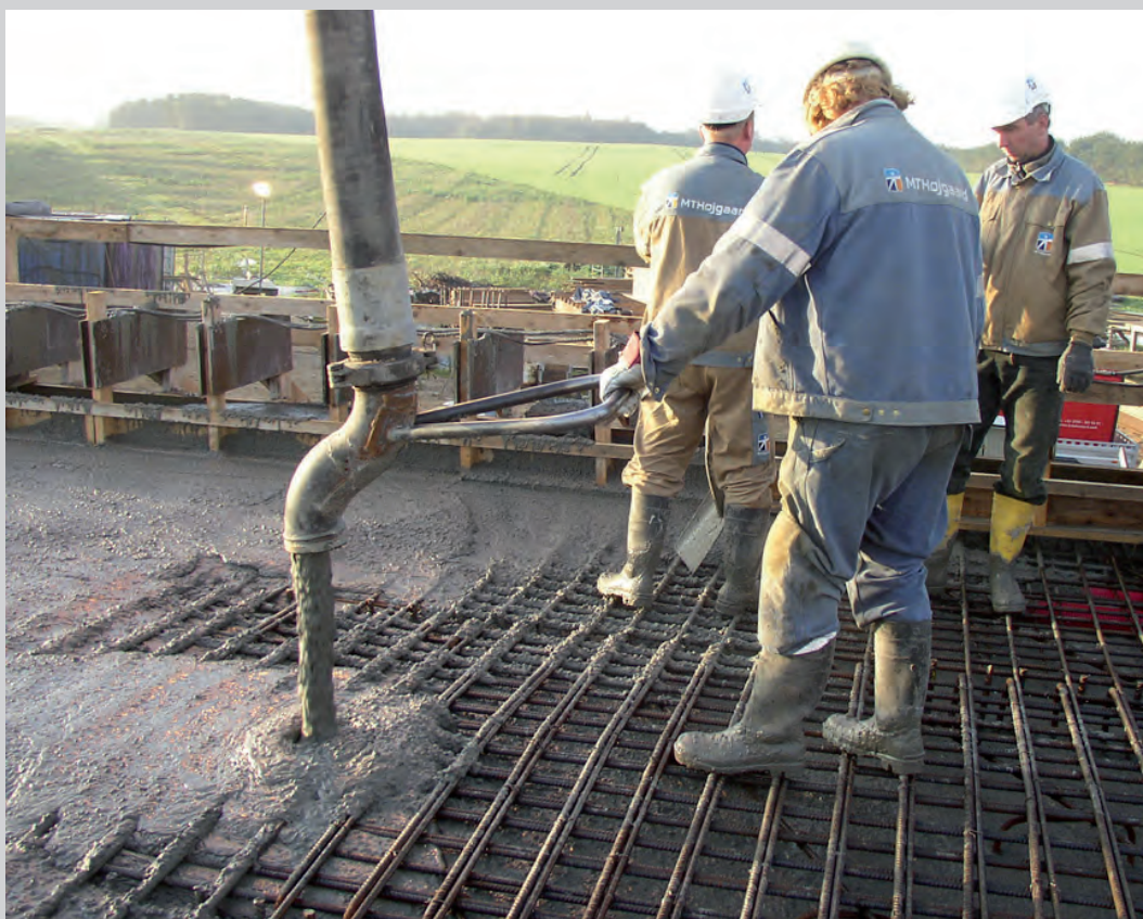
Figur 2.5. Pumpning af SCC til vandrette støbninger. Pumpemanden styrer pumpeslangens udløb, mens en pumpeoperatør styrer selve pumpens bevægelser og pumpetrykket.
