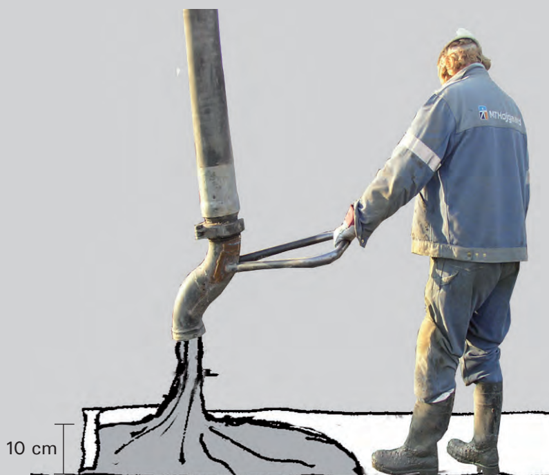
Figur 4.3. Eksempel på gulvstøbning med et lavt udbredelsesmål på ca. 525 mm. God kontrol over støbefronten, hvor det er nemt at nå færdig støbehøjde (fx 100 mm) i en og samme arbejdsgang.
