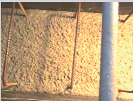
Figur 2.9. Ingen separation (mange sten i overfladen) – Der kan etableres ru støbeskel.
