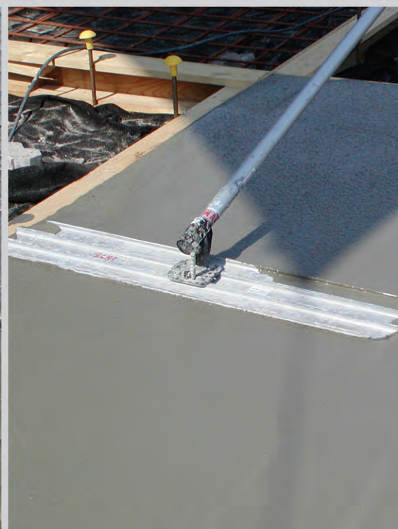
Figur 4.6. Øverst til højre: Curing membran sprøjtes på. Det bør ske hurtigst muligt efter endt overfladebehandling. Øverst til venstre: Jutning af overfladen for at dykke stenene. Bør kun foretages, hvis der er sten i overfladen. Nederst til højre: Overfladen afrettes med en planafretter. Det anbefales ikke at benytte den, når der er mange sten i overfladen, da det kan trække spor af sten. Nederst i midten: SCC med separation. Der er ingen sten i overfladen eller lige under. Desuden bobler overfladen pga. ustabil luft. Nederst til venstre: SCC uden separation. Tydelige sten i overfladen.
