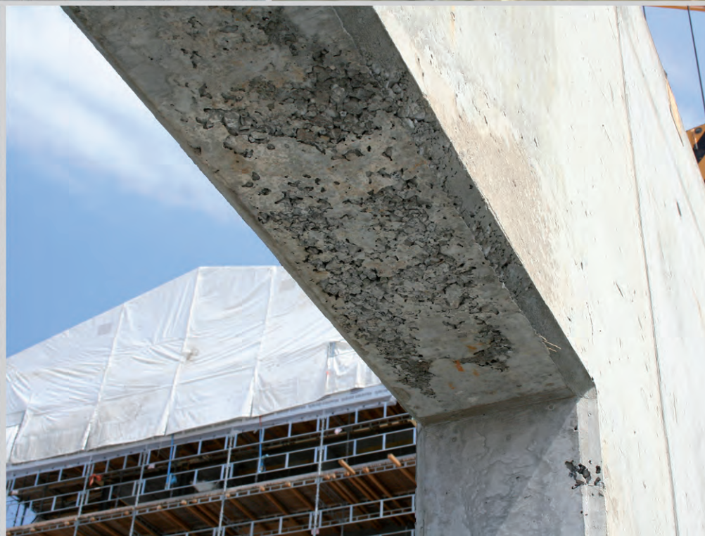
Figur 2.12. Blokering ved SCC støbning. Eksempler på tæt armering og ophobning af sten bag armering og stenreder.
