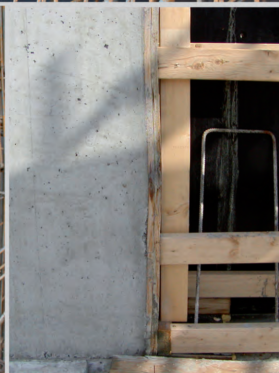
Figur 2.3. Forberedelser af vægform i ca. 4 m højde. Eksempel på udsparinger i vægform. Nederst til højre ses, hvordan den lodrette træstolpe ikke har været afstivet tilstrækkeligt for hydrostatiske støbetryk og bøjer let indad. Risikoen for skader mindskes ved at holde samme støbehøjde på hver side af udsparingen, dvs. formfyldningen foregår skiftevis på hver sin side af udsparingskassen.
