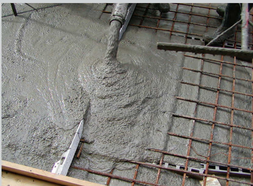
Figur 4.5. Til venstre: udstøbning af SCC. Til højre: Grovfordeling af SCC med skraber. Bemærk at betonen udlægges med pumpe-slangen placeret vandret langs med støbeunderlaget.
