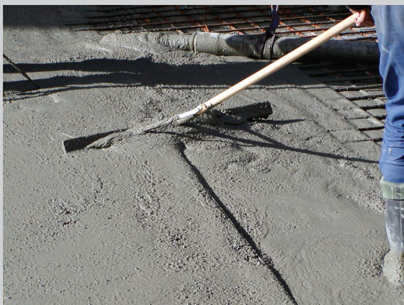
Figur 4.5. Til venstre: udstøbning af SCC. Til højre: Grovfordeling af SCC med skraber. Bemærk at betonen udlægges med pumpe-slangen placeret vandret langs med støbeunderlaget.
