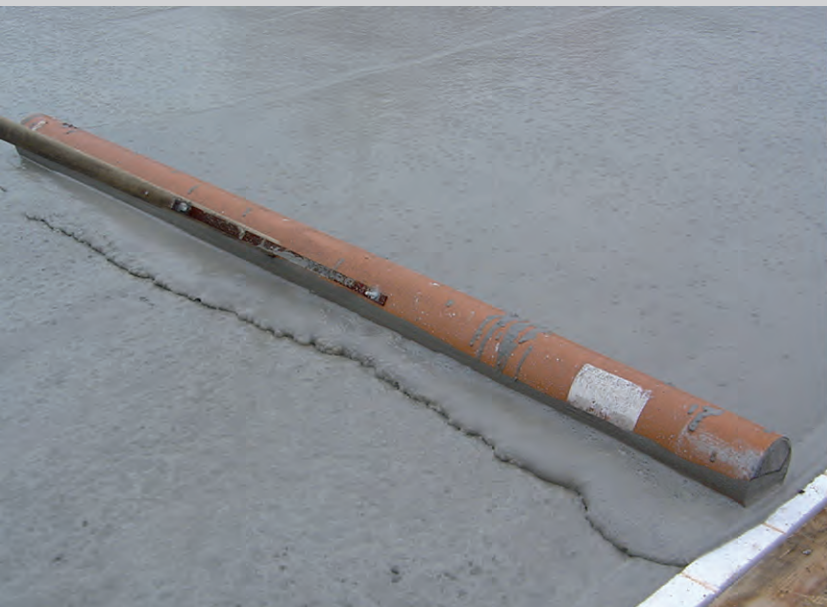
Figur 2.8. Separation ved vandret gulvstøbning.
