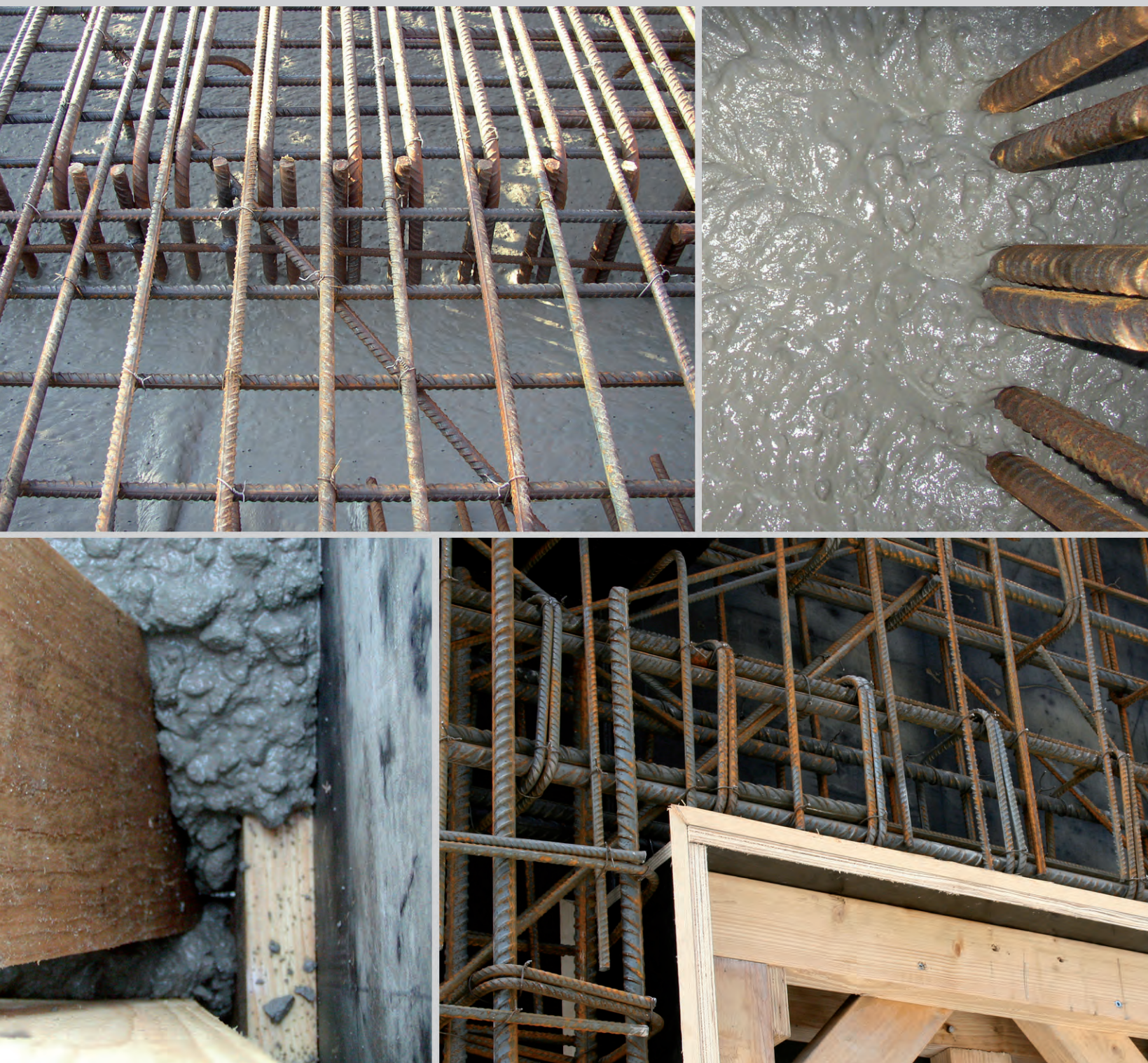
Figur 2.13. Ingen blokering. SCC flyder fint omkring armering uden at sten ophobes.
