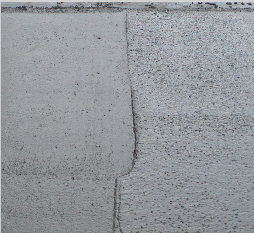
Figur 4.7. Øverst til venstre: SCC gulv glittes. Det er en erfaringssag at vurdere det korrekte glittetidspunkt. Især ved større gulvarealer er det vigtigt at være opmærksom på en ensartet levering til pladsen, da det ellers giver uens overfladekvalitet der vanskeliggør glitning. Øverst til højre: SCC overflade afsluttet med 25 promilles tværfald. Nederst til venstre: Planafrettet (venstre) og juttet (højre) overflade af SCC med lavt flydemål på ca. 480 mm og relativ høj viskositet. Planafretteren trækker tydelige spor efter sten mens jutteren har lidt svært ved at dykke stenene. Nederst til højre: Eksempler på forskellig overflade på det samme gulv – glittet, slebet og kostet.
