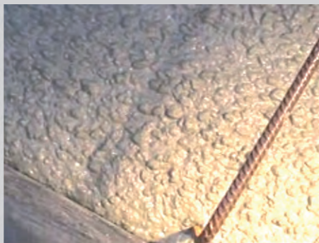
Figur 2.9. Ingen separation (mange sten i overfladen) – Der kan etableres ru støbeskel.
