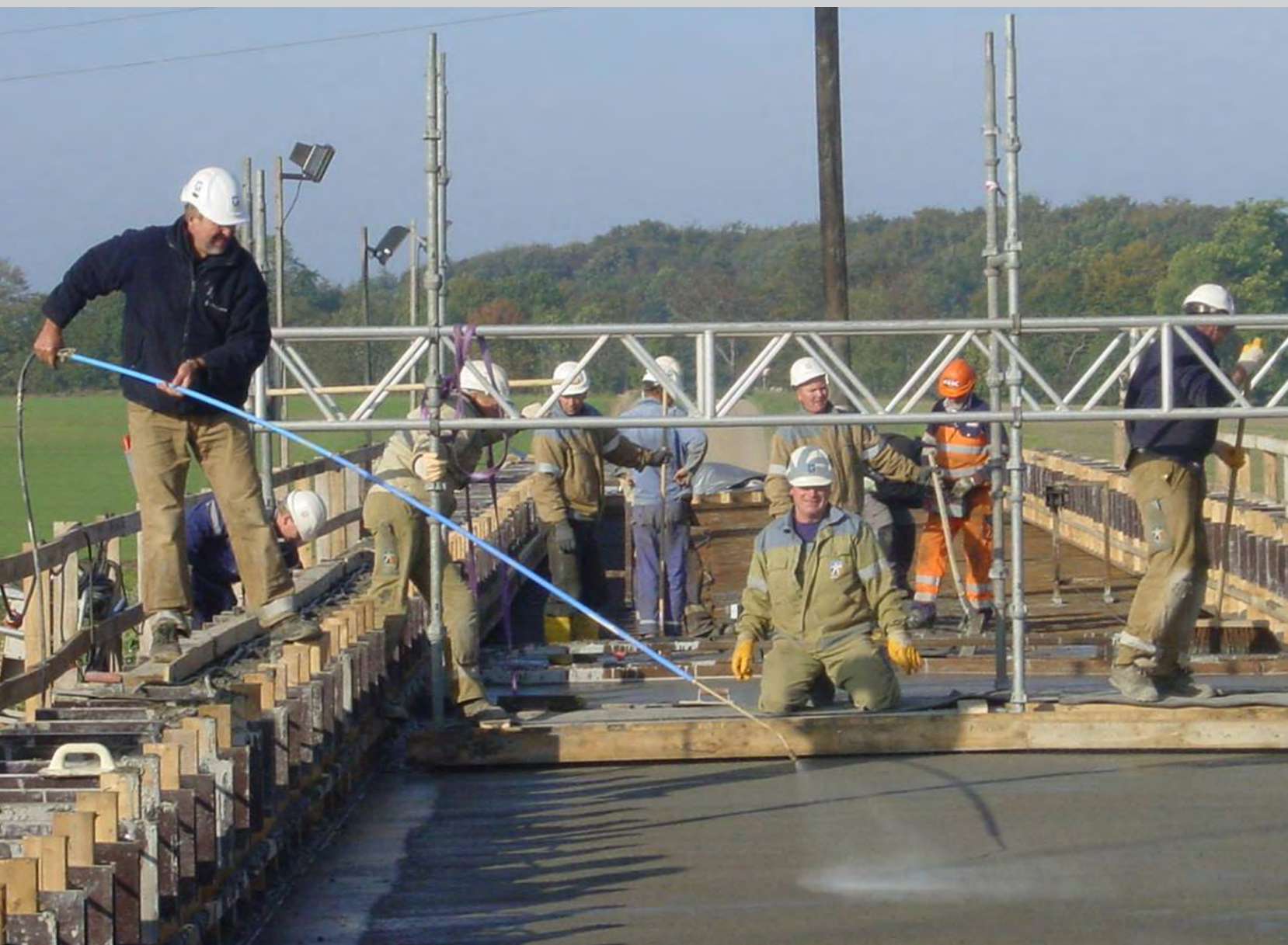
Figur 2.16. Påføring af curing membran på SCC brodæk. Der afdækkes efterfølgende med plastik som vist på figur 2.15.
