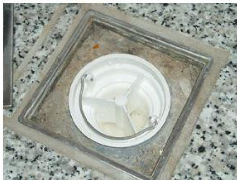
Synlig beton og utæthed ved risteramme
