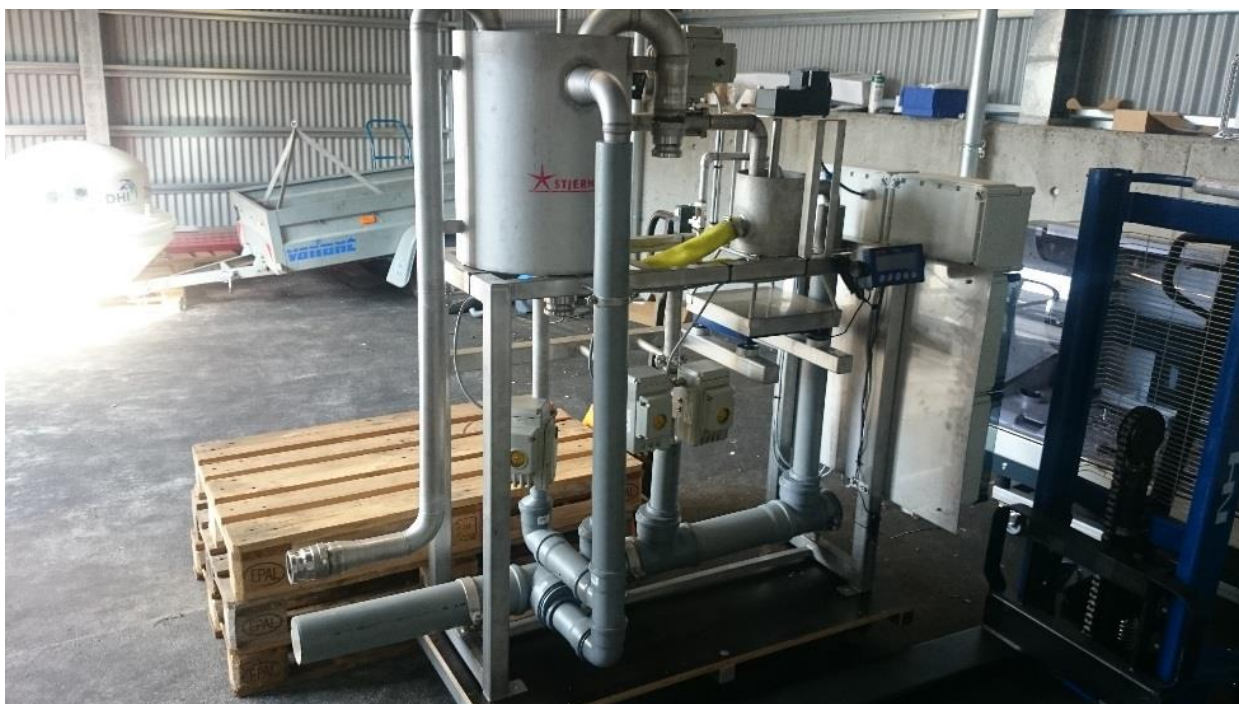
Figur 10: Fotografi forud installation i målestationstraileren. Pumpe 2 er endnu ikke installeret.
