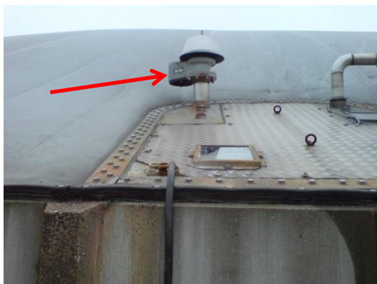
Figur 5. Eksempel på lækage fra tryk/vakuumsikkerhedsventil.
