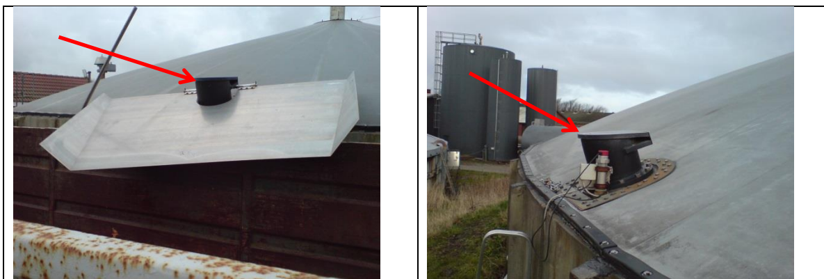
Figur 7. Eksempler på lækager i forbindelse med klapventiler.
