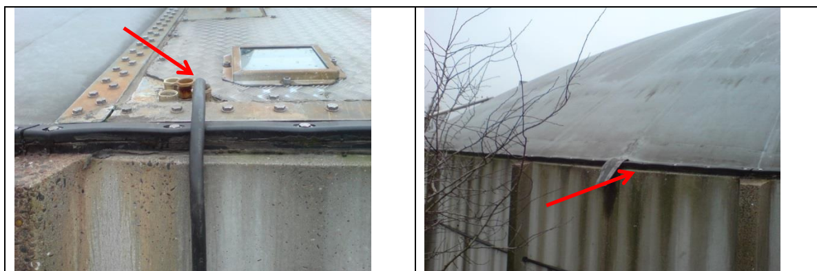
Figur 1. Eksempler på lækager ved samlinger. Til venstre ses lækage ved slangegennemføring. Til højre ses lækage ved samling mellem betonvæg og membran på efterafgasningstank
