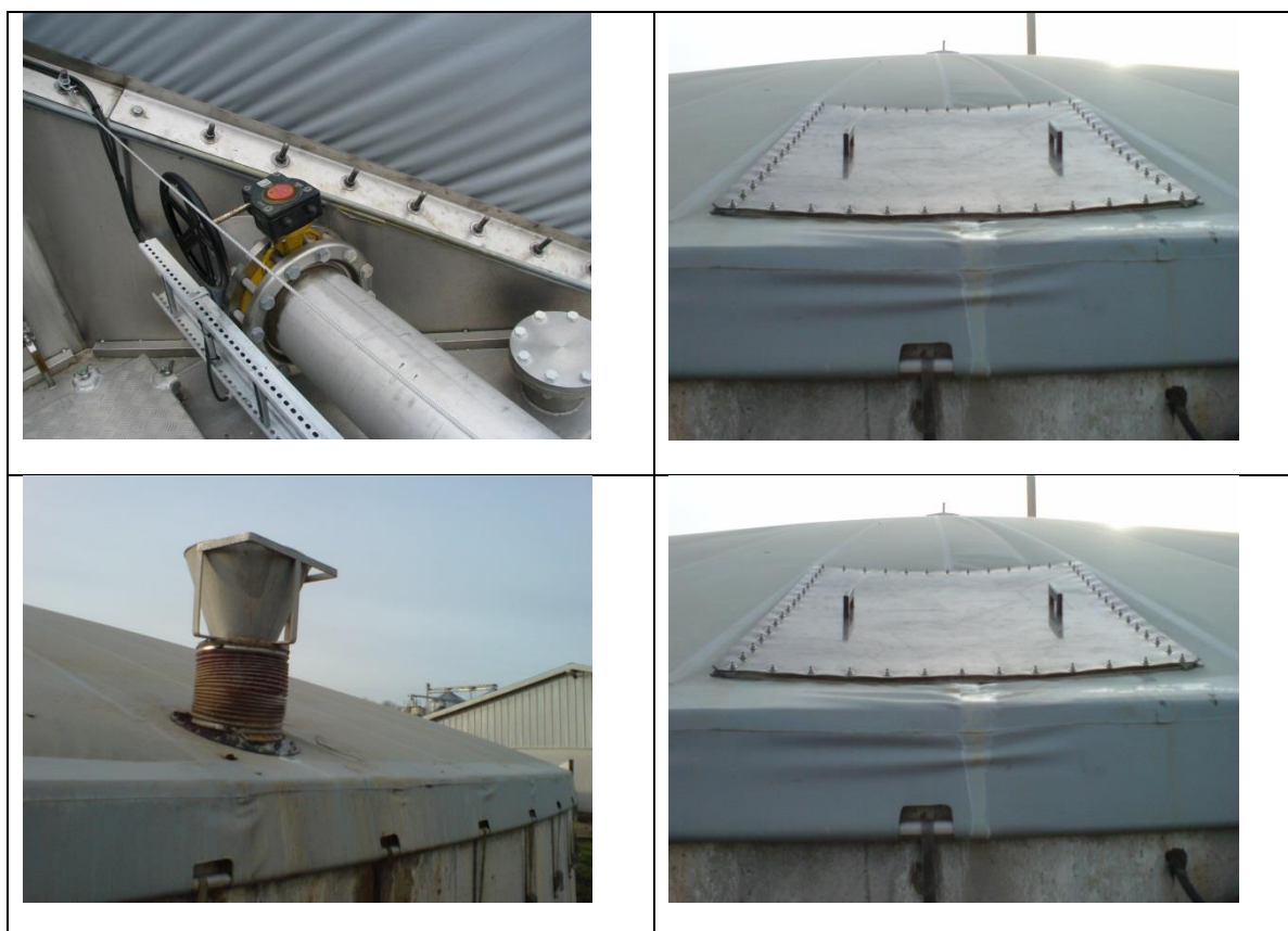
Figur 2. Eksempler på lækager ved samlinger på nyetablerede duge på efterafgasningstanke. Alle lækager blev detekteret i 2. målerunde, og der er således ikke registreret hvilke løsninger, der er anvendt til udbedring af lækagerne.
