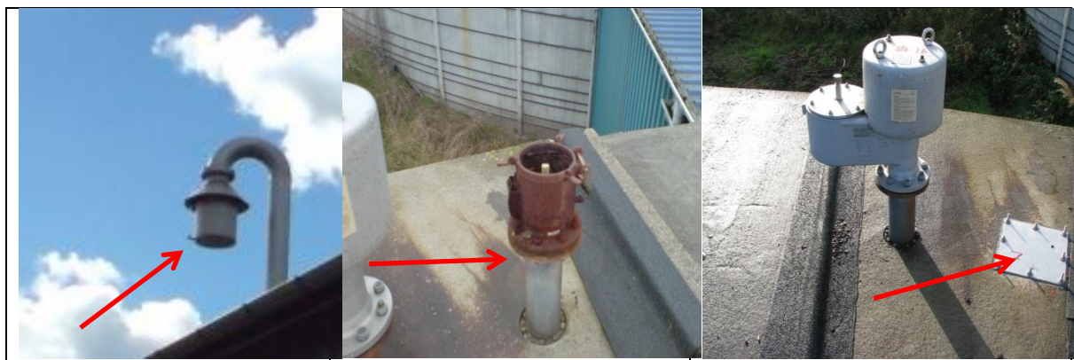
Figur 4. Eksempler på sikkerhedsventiler på biogasanlæg. Billedet til venstre er en vandlås på gaslager. Det midterste billede viser en gammel inaktiv og utæt sikkerhedsventil, som på billedet til højre er afmonteret, hvorefter hullet er lukket med metalplade.
