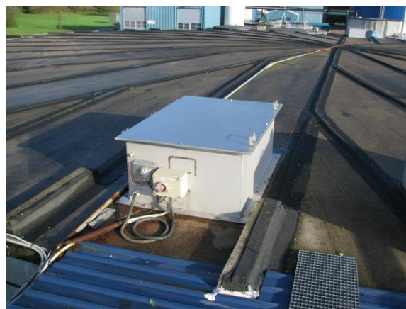
Figur 8. Metalkasser på toppen af efterafgasningstanke, som sikrer adgang til omrører. Til venstre en ældre kasse, som på billedet til højre er udskiftet med en ny.
