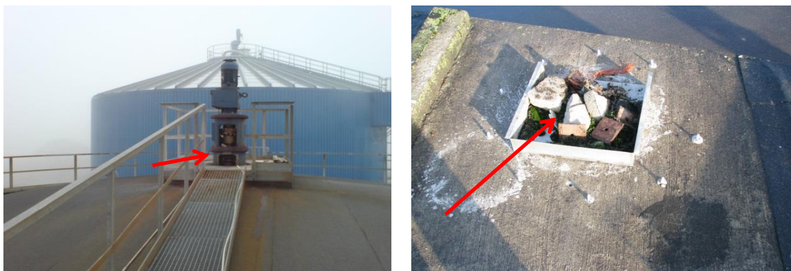
Figur 11. Til venstre: Pakdåse ved omrører. Til højre: hul i efterafgasningstak. Biogasanlægget var bekendt med hullet, og det var planlagt, at der snarest skulle monteres en metalplade til afdækning.
