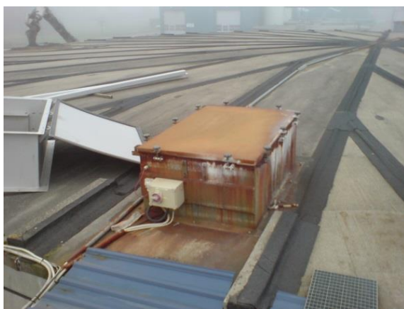
Figur 8. Metalkasser på toppen af efterafgasningstanke, som sikrer adgang til omrører. Til venstre en ældre kasse, som på billedet til højre er udskiftet med en ny.
