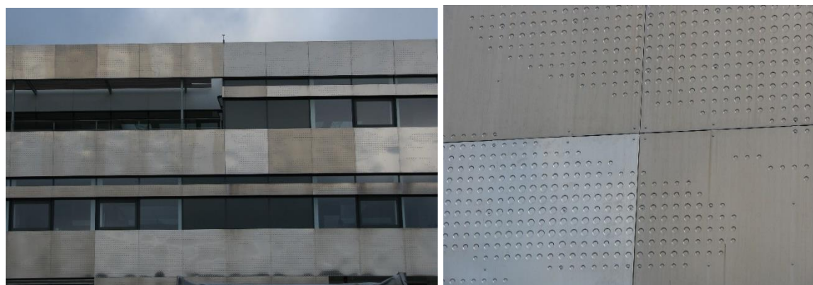
Figur 1: Aluminiumsplader på en bygningsfacade med vidt forskelligt visuelt indtryk pga. ikke-kontrolleret patinering.
