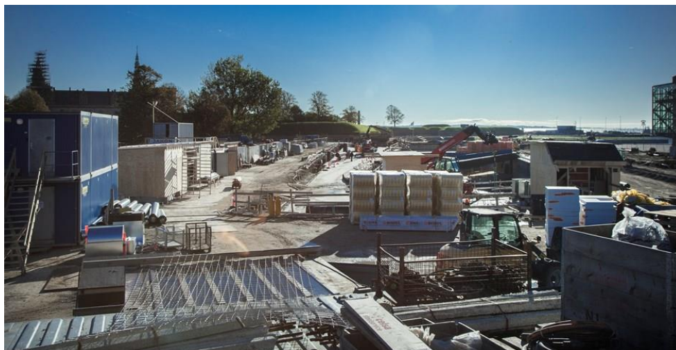
Figur 3: Billede af byggeplads med masser af materialer opbevaret på forskellige måder (fra Branchearbejdsmiljørådet for Bygge & Anlæg, www.bar-ba.dk ).
