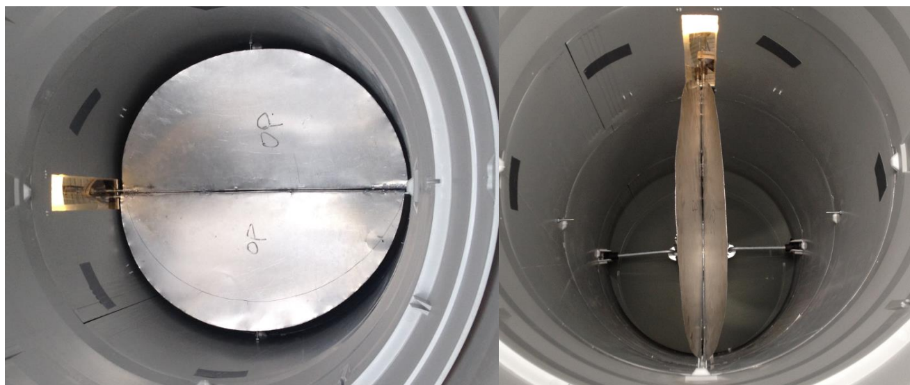
Billede 11 – Vinkel flowmåler, hvor klapperne på venstre billede er lukkede og højre billede åbne.
