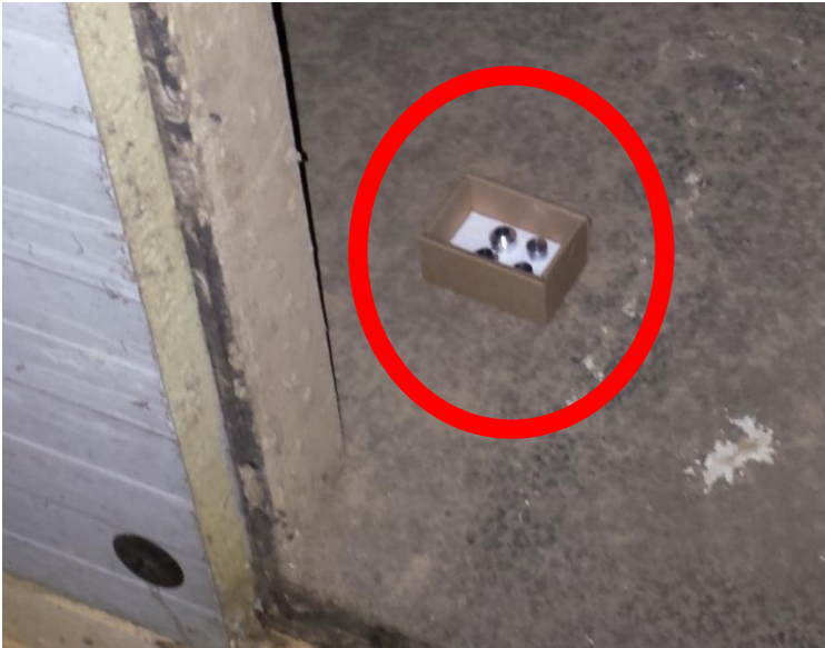
Billede 29 – Indkapslede ultralydssensorer placeret i den fælles luftskakt før luftrensningsanlægget.
