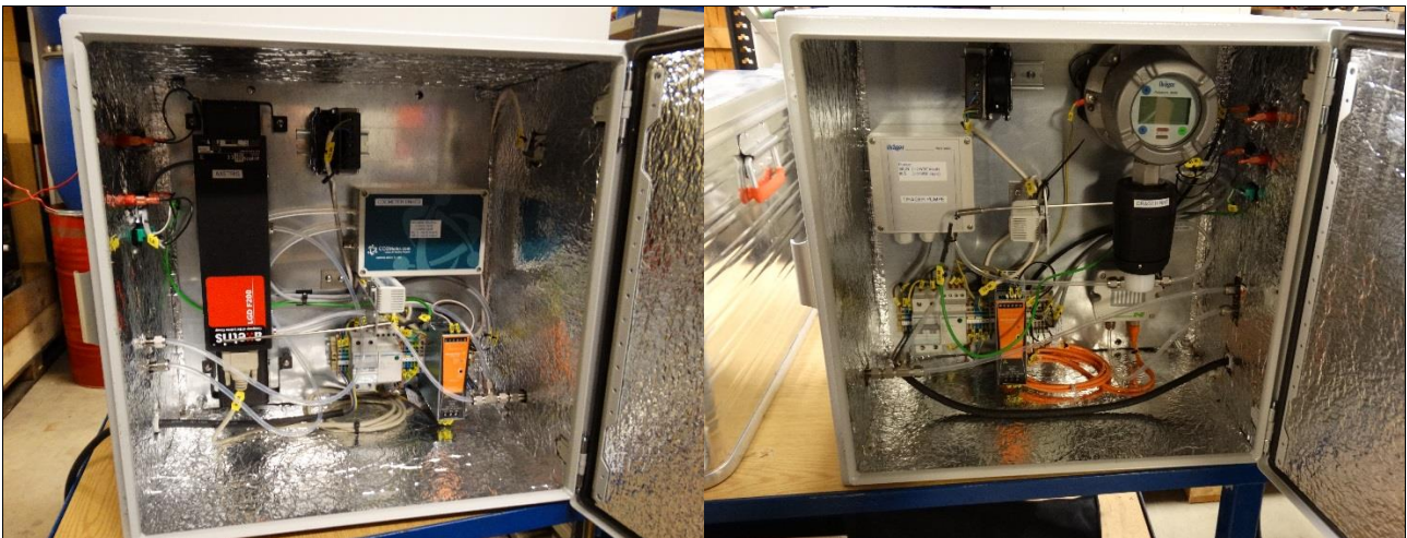
Figur 32: Axetris enhed (anvendt til måling af ammoniak) uden tegn på påvirkning fra atmosfærisk korrosion.
