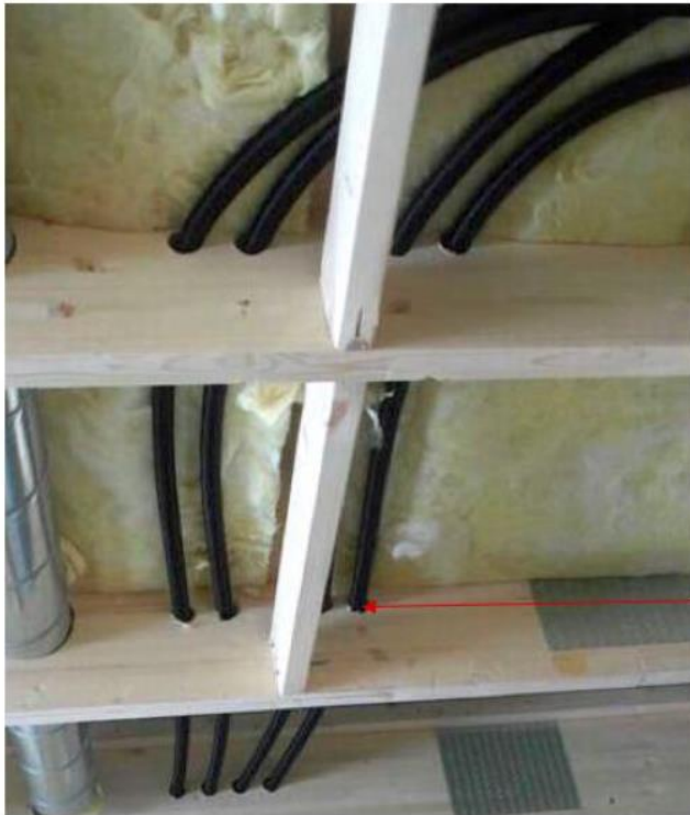
Figur 53: Tappevannsrør ført i himling uten klamring. Foto: Gruppe 13.
