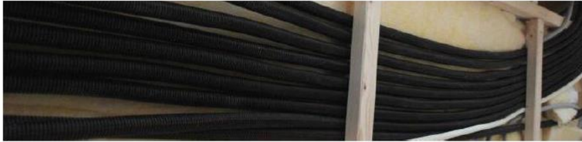
Figur 53: Tappevannsrør ført i himling uten klamring. Foto: Gruppe 13.
