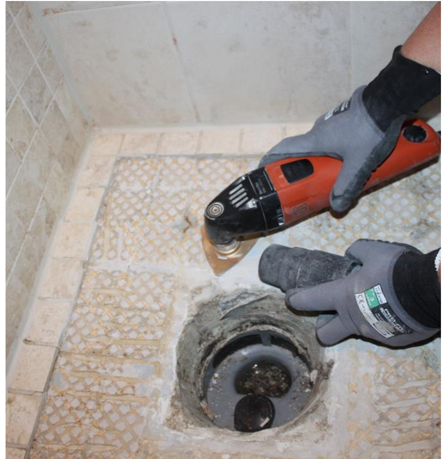
Skifting av slukmansjett krever presisjon og kunnskap.
