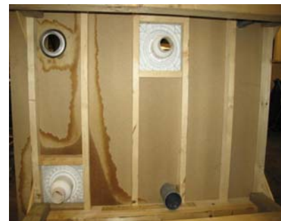
Alla tätskikt har monterats av respektive tillverkare
