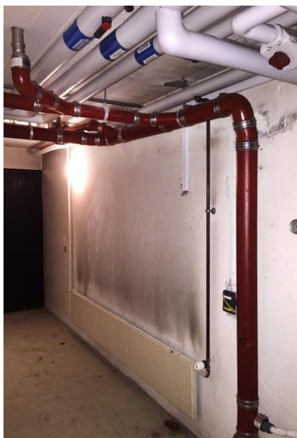
Figur 2.2. Total udskiftning af faldstamme i støbejern
