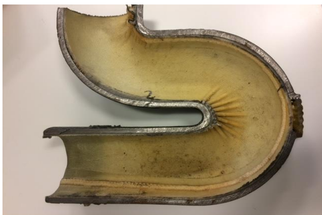
Figur 7.6. Renovering af vandlåse med strømpeforinger kan medføre folder i bøjningerne
