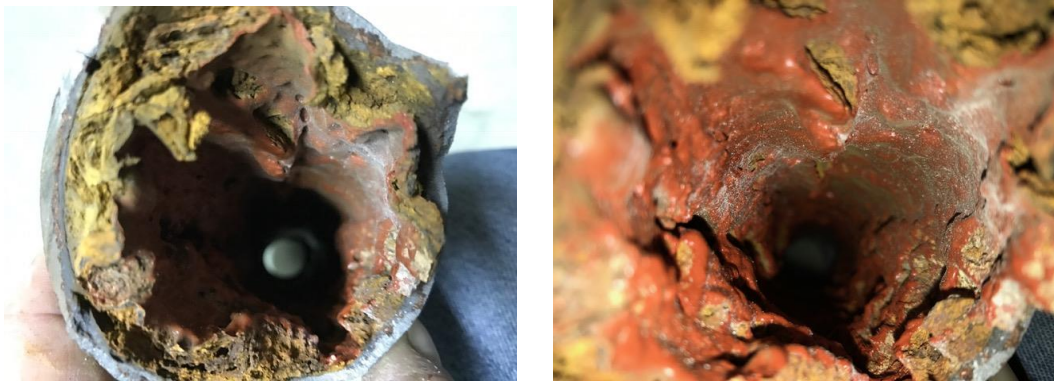
Figur 6.7. Eksempler på renoveringer udført i en faldstamme der ikke er rensed
