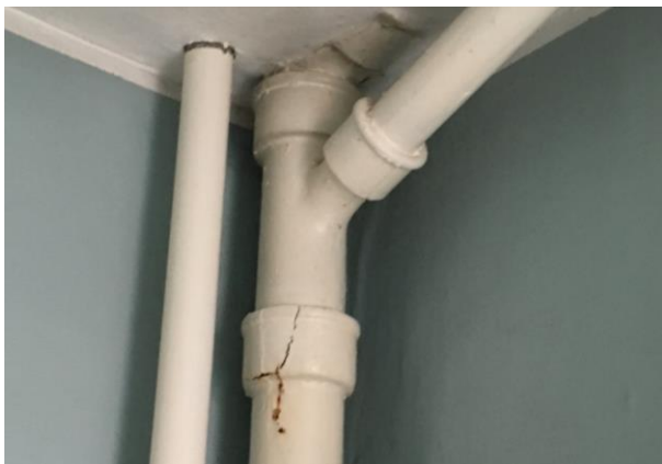
Figur 6.2. Her ses en synlig udvendig rustudfældning
