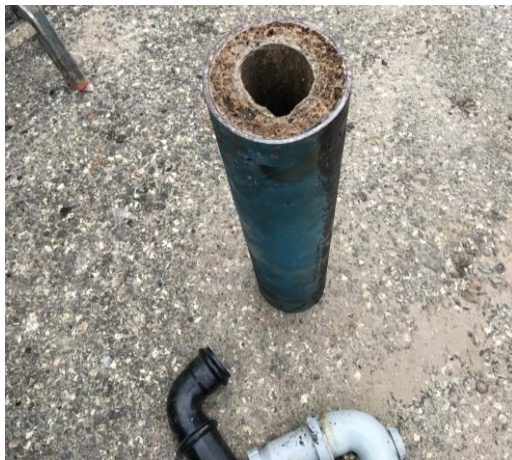
Figur 6.4. Faldstamme med faste aflejringer og fedt/rust mm.
