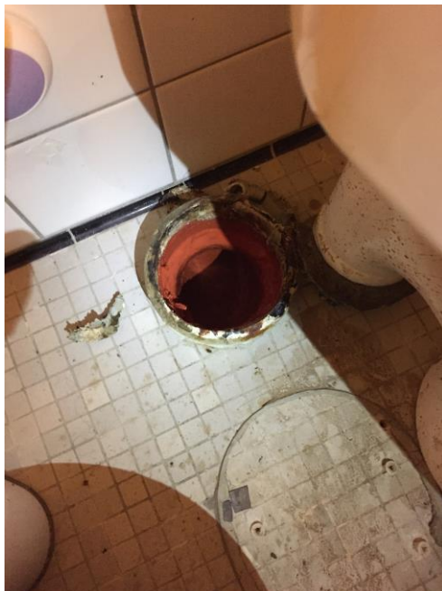
Figur 2.6. Toiletafløb behandlet med coating under 1mm
