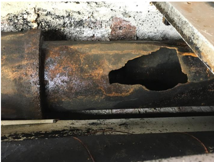
Figur 6.6. Faldstammer med større huller og gennemtæringer kan være vanskelige at rens
