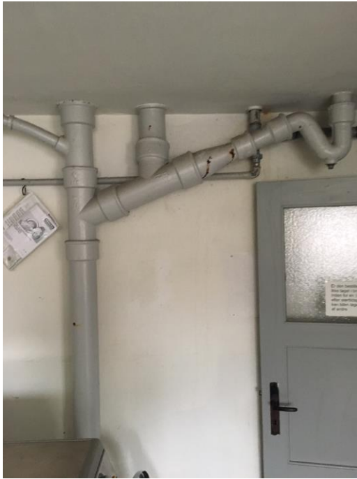
Figur 6.3. Synlige ledninger i kælder kan udskiftes i stedet for at blive renoverede
