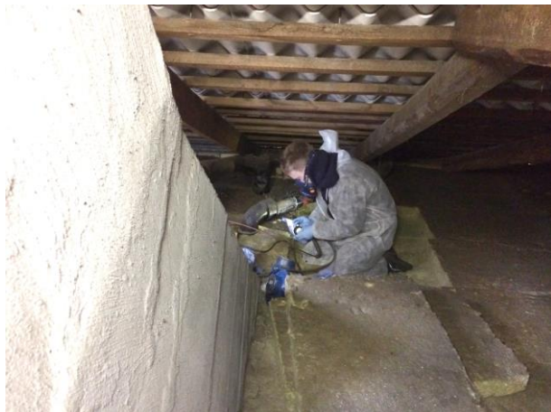
Figur 7.5. Faldstammer kan være vanskelige at komme til. I dette tilfælde var det nødvendigt at anbringe udstyret oppe på et trangt loft
