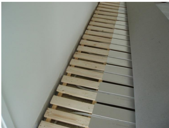
Figur 1.4: Det er gulve af f.eks. denne type, hvor man skal man regne med standardens forsigtige værdier for de kritiske modstande
