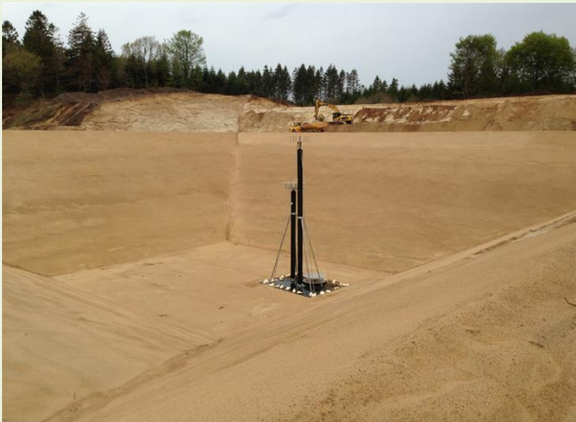
Udgravning afsluttet. Ind- og udløb etableret
