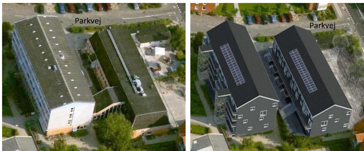
Figur 1.1: Sems Have før renoveringen til venstre og efter renoveringen til højre. Blok A er bygningen til venstre i de to billeder.
