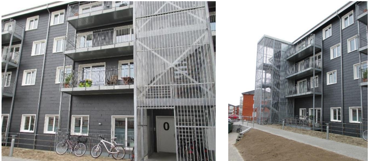
Figur 3.16: Blok A's vestlige facade med trappetårne.
