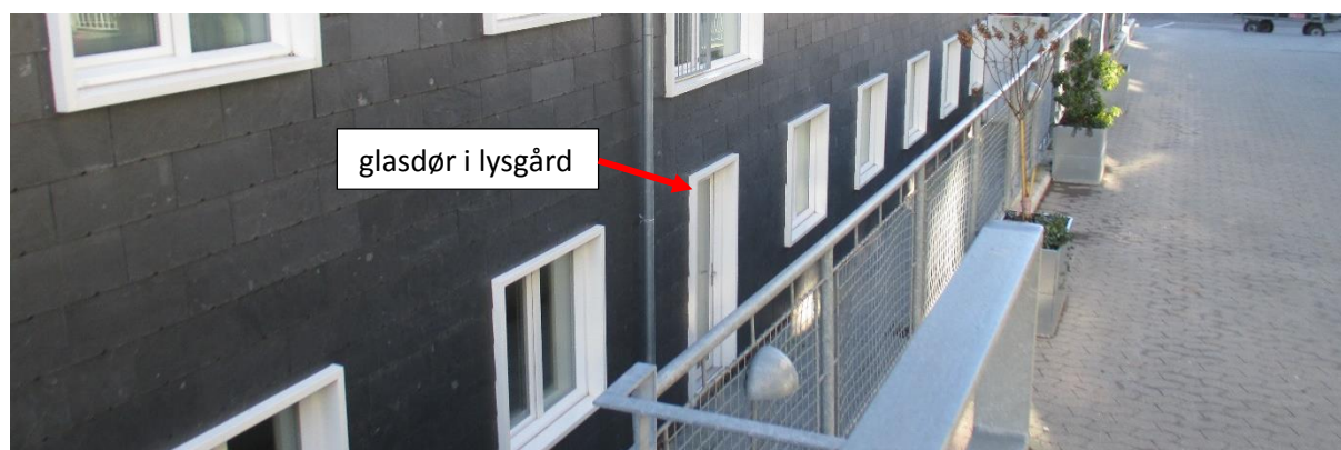
Figur 3.18: Vinduer og dør i lysgård.
