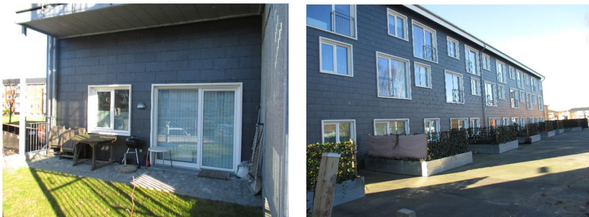
Figur 5.2: Små haver i stueetagen. Blok A til venstre og Blok B til højre.
