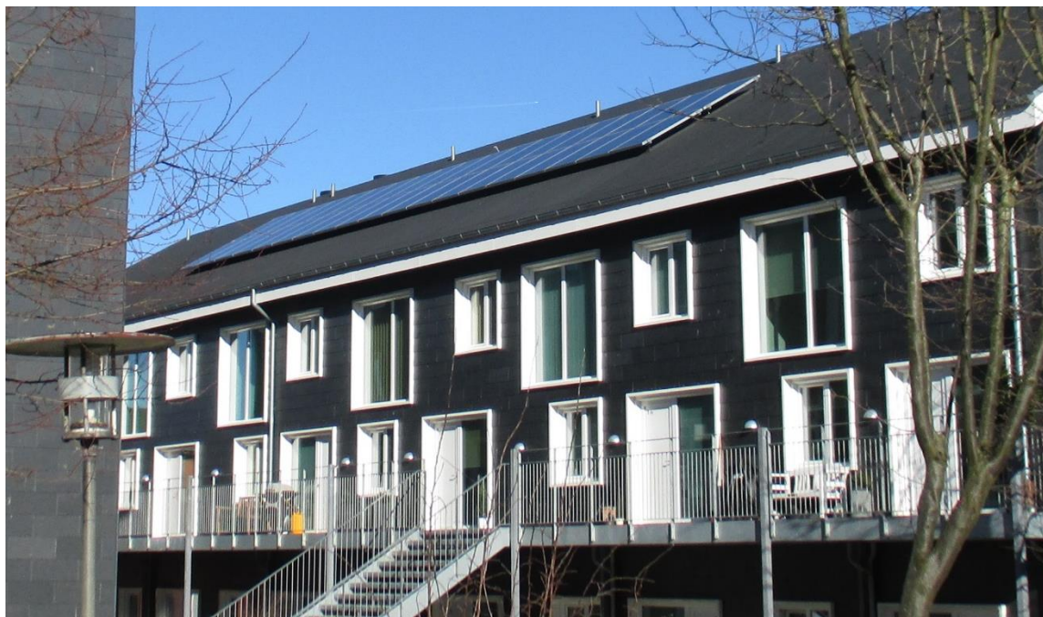
Figur 4.6: Solcelleanlægget på taget af Blok B.
