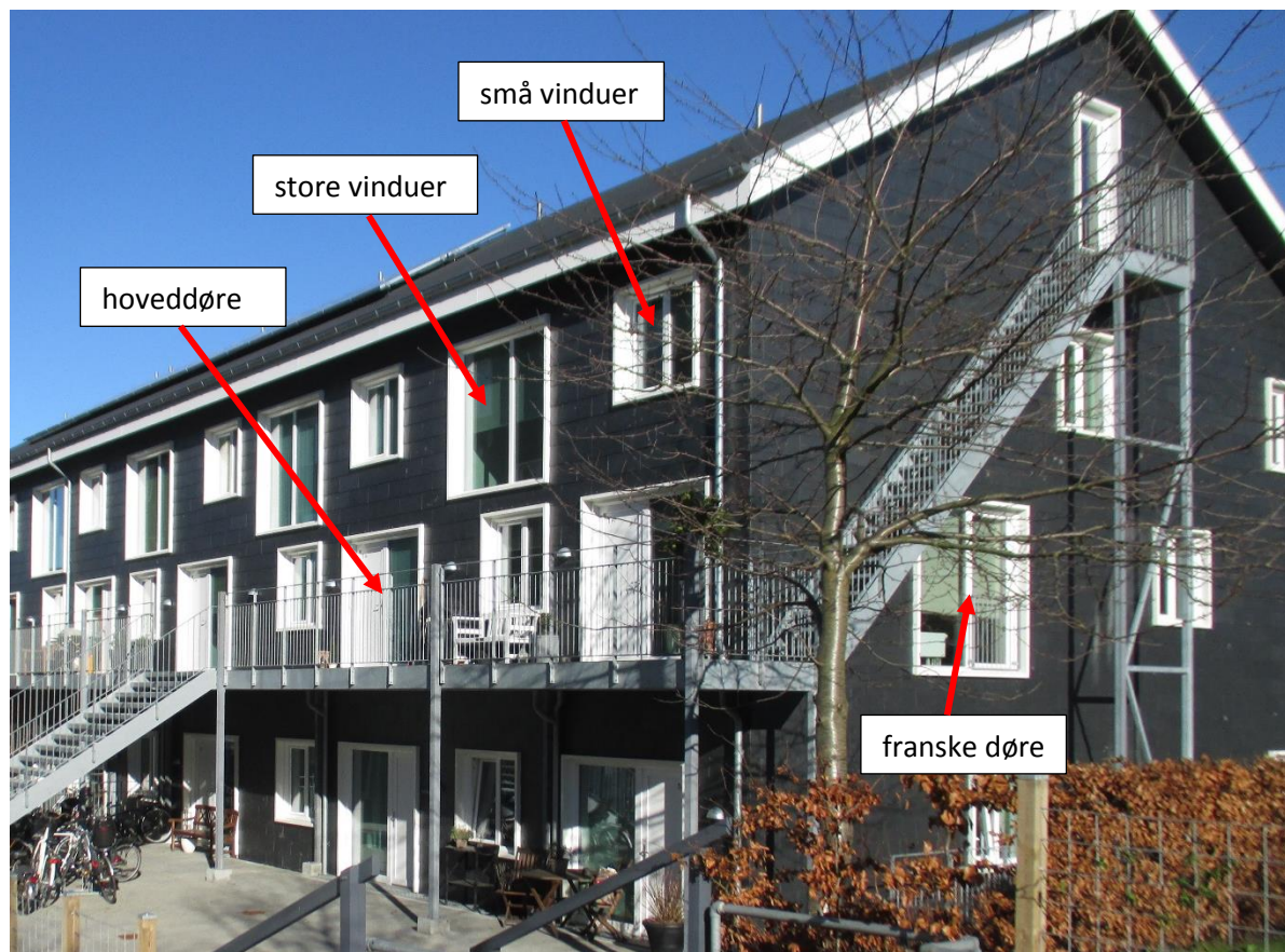
Figur 3.17: Forskellige typer vinduer og døre efter renoveringen.
