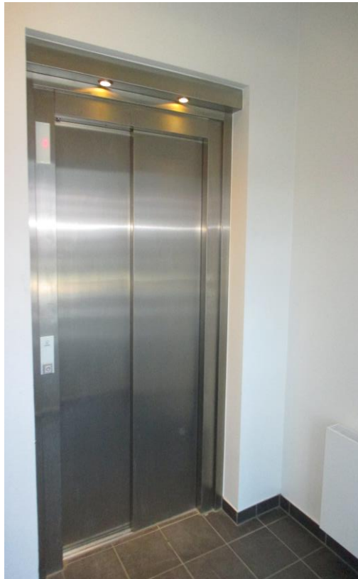
Figur 4.5: LED spot over dørene til elevatorerne.
