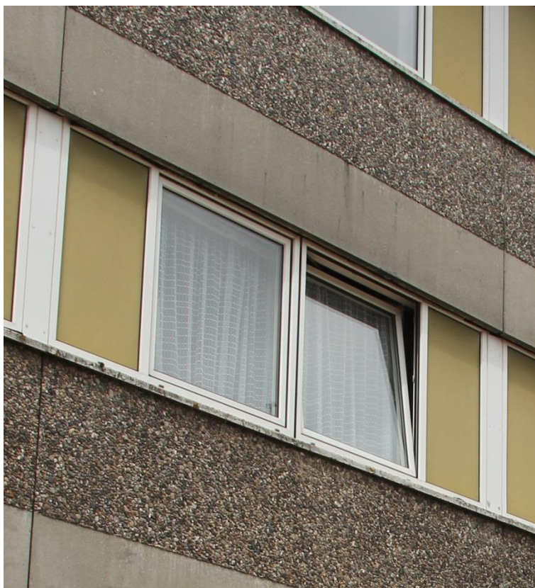
Figur 3.10: Gamle vinduer med 2-lags termoruder.
