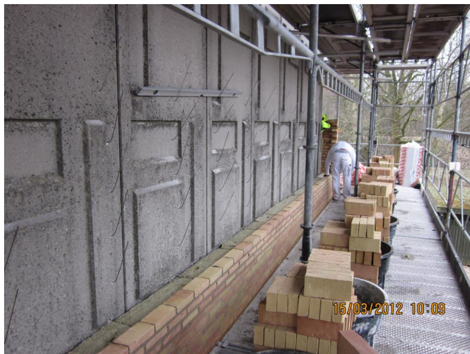
Figur 3.1: Efterisolering og opmuring af gavl.
