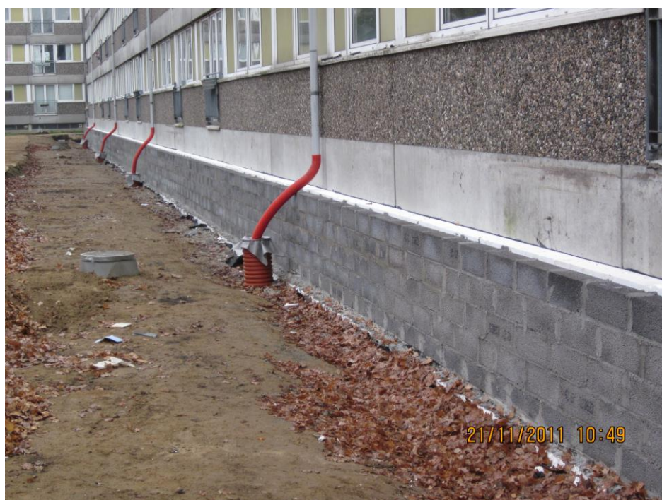
Figur 3.3: Kælderydervægge færdiggjort.
