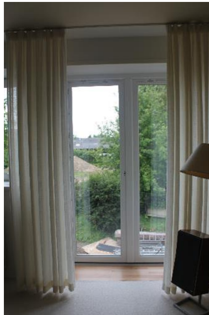
Figur 3.14: Ny altandør med lavenergirude.
