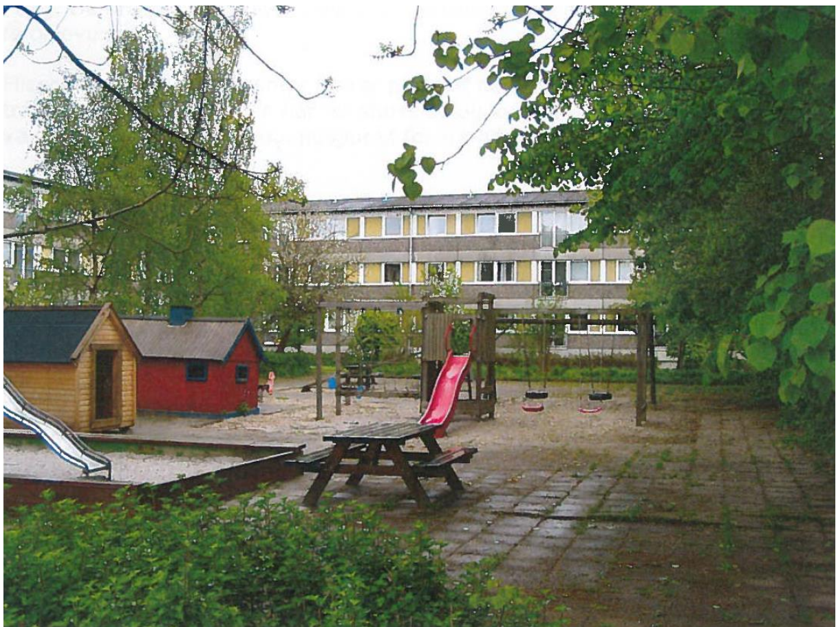
Figur 5.3. Gårdrum før renovering.
