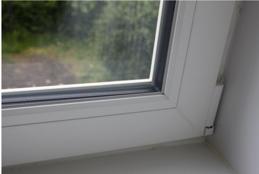
Figur 3.13: Nederste hjørne af et vindue med 3-lags lavenergirude.
