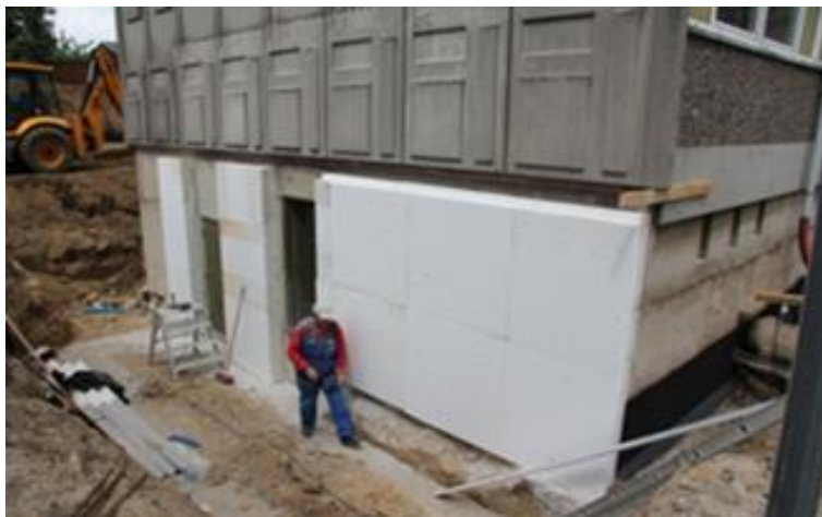
Figur 3.2: Efterisolering af kælderydervæg.
