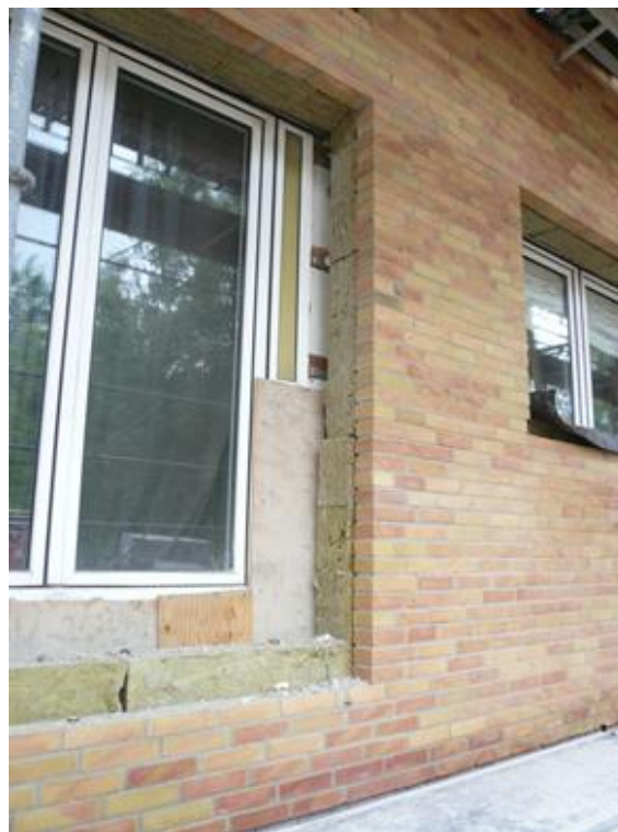
Figur 3.5: Ny isolering af klimaskærmen samt gamle vinduer.
