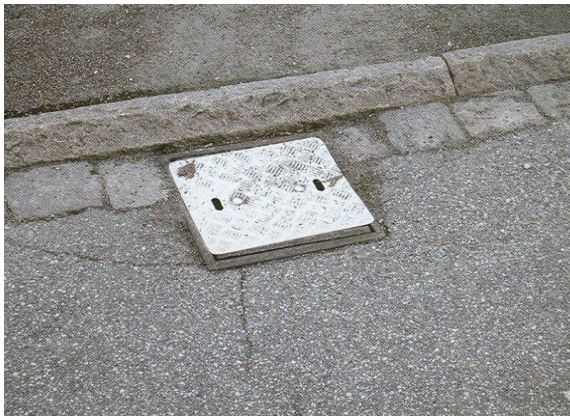
Figur 4: Midlertidig afblænding af nedløbsbrønd i vej.
