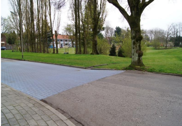
Figur 5: Fortsættelse af vandføring efter fordybning i vej. Fotoet stammer fra internettet og hvorvidt der er tale om et T-kryds, eller blot en afvanding af en vej via en fordybning vides ikke, men det ses tydeligt hvordan vandet fanges fra vejen og ledes via en rende ind i den tilstødende park. Fordybningen er udført i et andet materiale end resten af vejen, hvilket kan have en god signalvirkning over for bilister.
