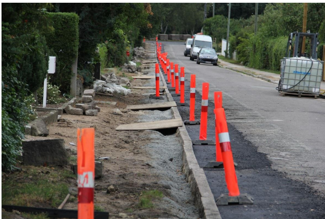
Figur 3: Kantstensopretning på Harboørevej i 2011. Foto: Grundejerforeningen.
