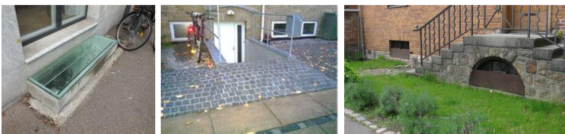
Figur 7.13. Eksempler på skybrudssikring af en bygning
