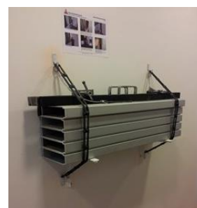
Figur 7.9. Geologisk Institut er blevet skybrudssikret med flytbare skots
