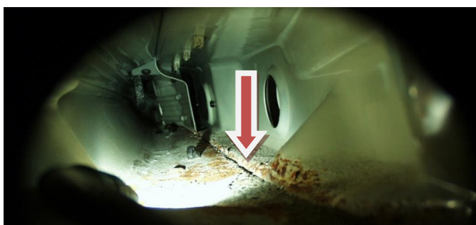
Stort hulrum med mange indvendige forstærkninger og pladesamlinger. Indvendig kritisk samling, som ofte er dækket af vand og snavs. Vigtigheden af tidlig forsegling af samlingen med et rustbeskyttende produkt er åbenlys.
