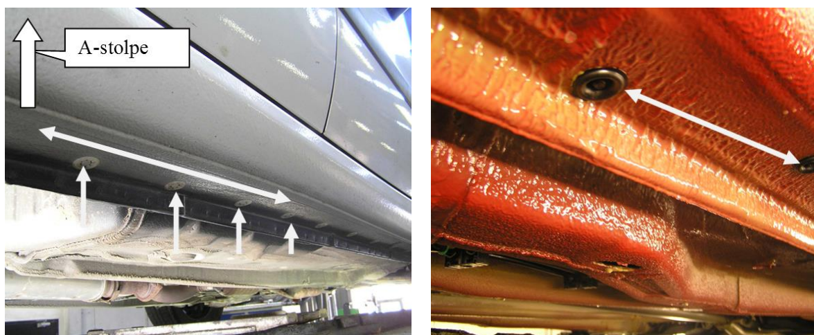
Behandling af hulrum i dørpaneler kræver at alle propper afmonteres, samt at der behandles gennem eksisterende huller i hhv. de forreste og bageste hjulkasser.
