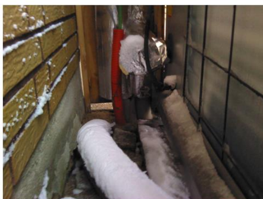
Figur 3.6 Luft/Vand-varmepumpeanlæg. Der er anvendt ubrugeligt isoleringsmateriale.
