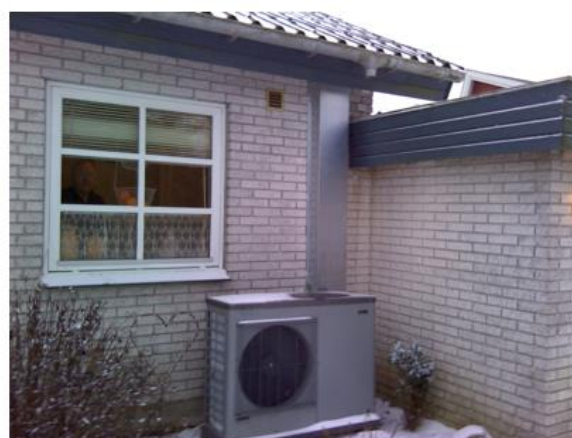
Figur 4.6 Eksempel på mangelfuld isolering af rør fra varmepumpen og ind til indemodulet. Øverst med dårlig isolering og nederst med korrekt udført isolering.
