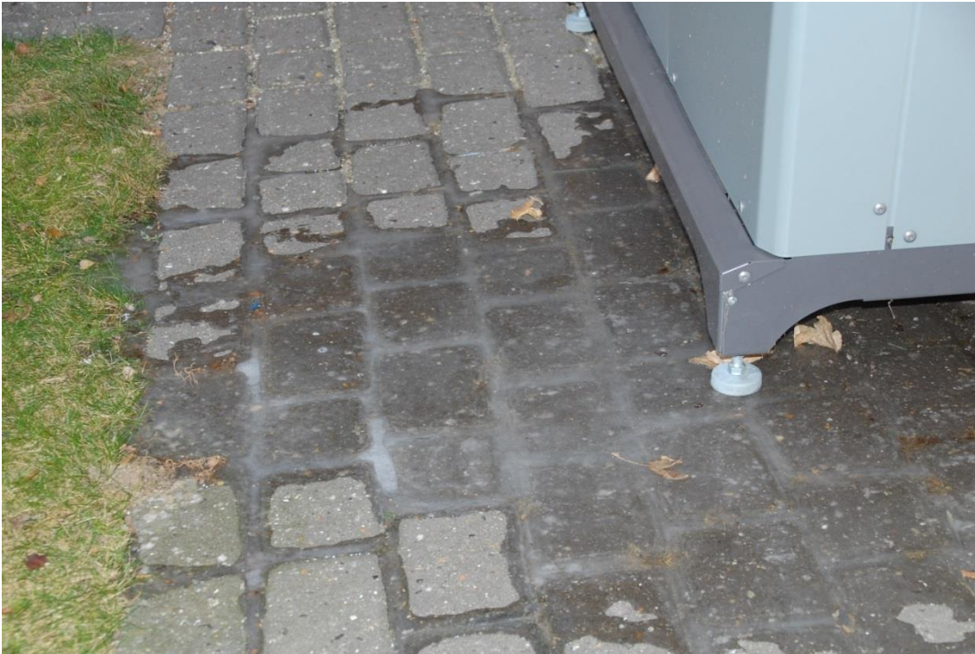
Figur 4.7. Afrimningsvandet ledes ud på jorden i stedet for til et afløb, som det burde
