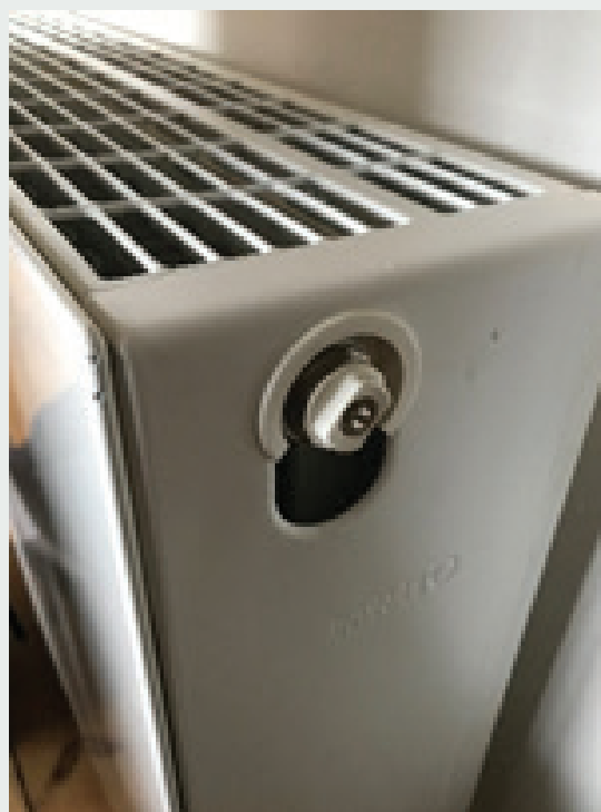
Figur 3 - Udluftningsventil
