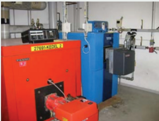
Figur 1. I forgrunden en traditionel ikke kondenserende kedel med gasblæsebrænder. I baggrunden en moderne kondenserende gaskedel med gasblæsebrænder
