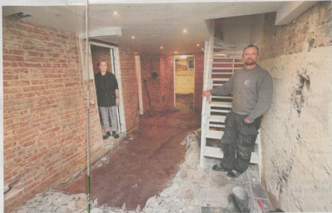
Indtil udsaltningsgen af kloakkerne på Nørholmvej, havde Charlotte Føjbjerg og Dennis Jensen en tør kælder. Efter kloakudskiftningen steg området grundvand og oversvømmende kælderen i panets hus. Tilsvarende problemer ventes ved den igangværende kloakudskiftning i Sunds, men her får husene mulighed for at købe sig til ekstra drænlægning i de offentlige kloaker, hvis vandet nu sætter sig i kloakledningen.
