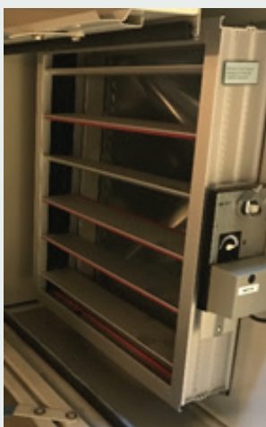
Figur 2: Afspærringsspjæld med motor (tv.), indreguleringsspjæld manuelt (mf. og th.)
