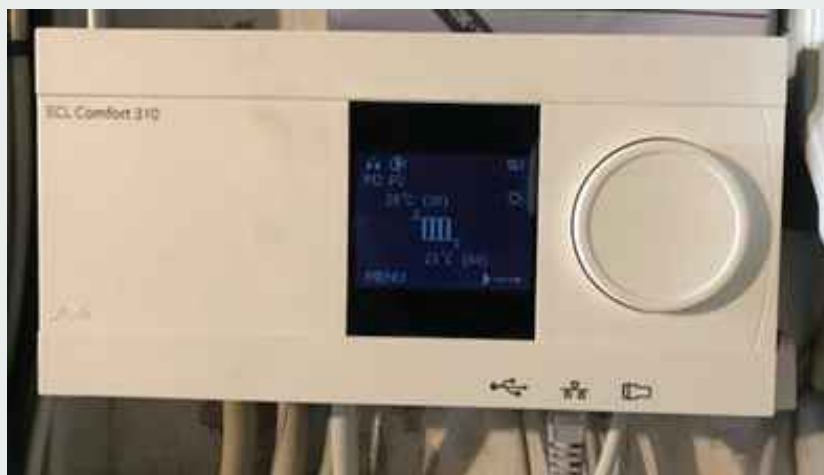
Figur 1 – Eksempel på vejrkompeniseringsanlæg; denne model har både central og lokal styring
