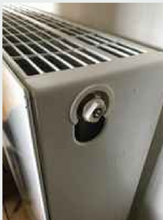
Figur 3 - Udluftningsventil
