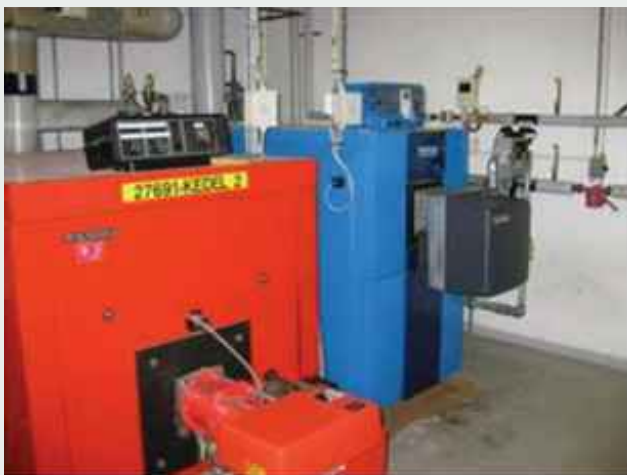
Figur 1. I forgrunden en traditionel ikke kondenserende kedel med gasblæsebrænder. I baggrunden en moderne kondenserende gaskedel med gasblæsebrænder
