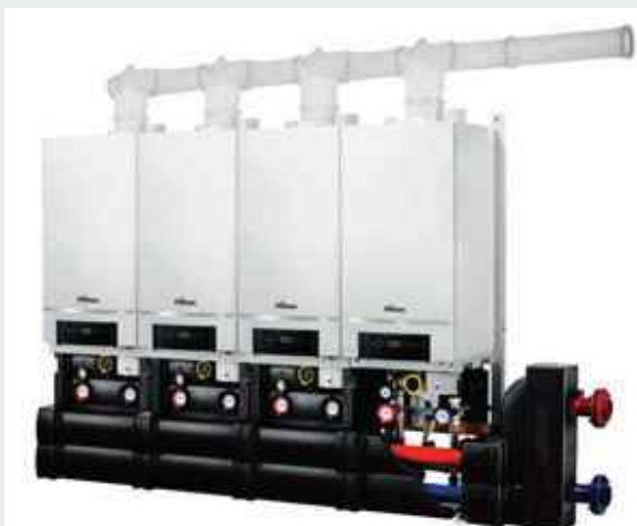
Figur 2. Kaskadekoblede gaskedler. I dag er denne type anlæg monteret med kondenserende kedler, men der eksisterer også ældre ikke kondenserende anlæg
