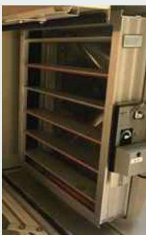
Figur 2: Afspærringsspjæld med motor (tv.), indreguleringsspjæld manuelt (mf. og th.)
