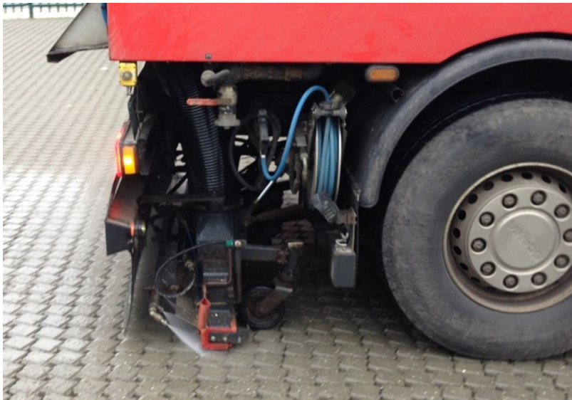
Figur 9.4.1: Permeable belægninger bør regelmæssigt, f.eks. årligt, renses for vejsnavs med spule-/sugebil for at sikre fortsat permeabilitet.
