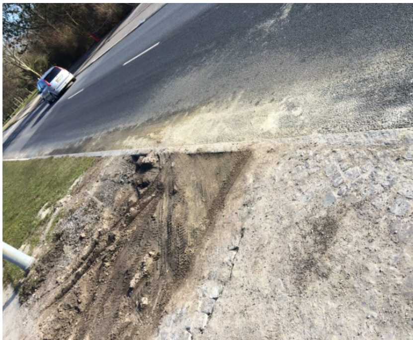
Figur 7.2-4: Belægningsoverfladen ved målepunkt 7 var tydeligt forurenet med sand ved måletidspunktet.
