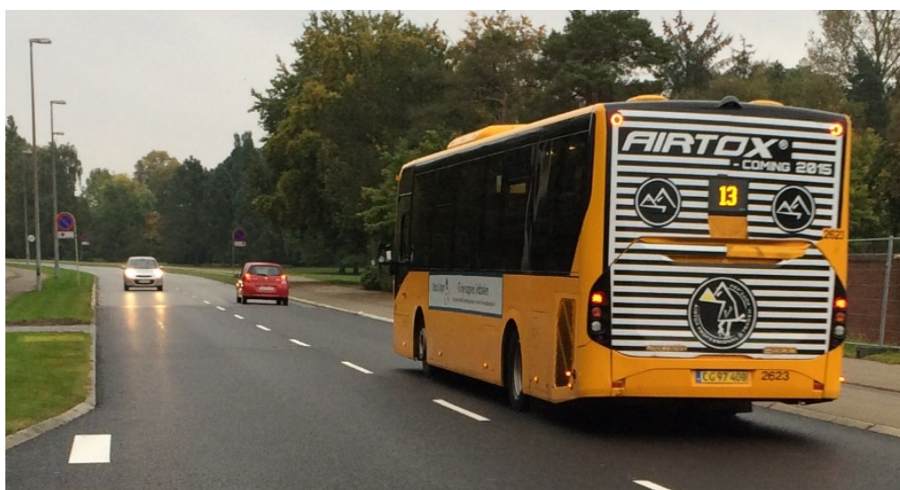
Figur 5.4-2: Trods hyppig bustrafik på fuldskala-forsøgsstrækningen på Korsdalsvej i Rødovre, ses ingen signifikant sporkøring eller instabilitet.
