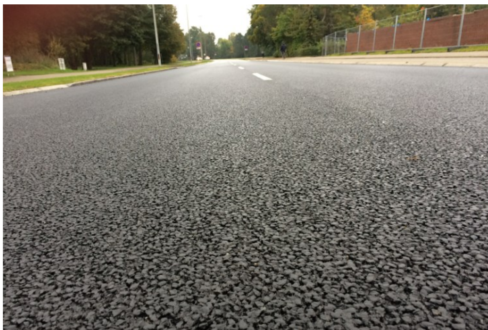
Figur 6.2-3: Multifunktionel Klimavej drænasfalt: Nydelig, plan og ensartet belægning med tydelig hulrumstruktur. Efter to ugers trafikpåvirkning samt vind og vejr er det initialt glinsende præg aftaget.
