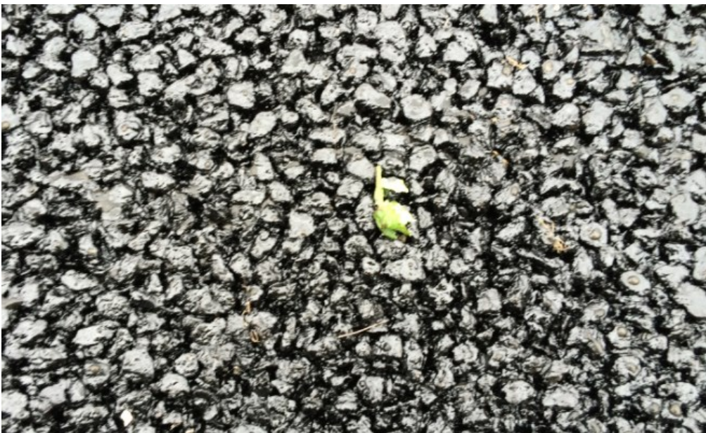
Figur 6.2-2: "Grøn" multifunktionel drænasfalt umiddelbart efter udlægningen. Bemærk den åbne porestruktur.
