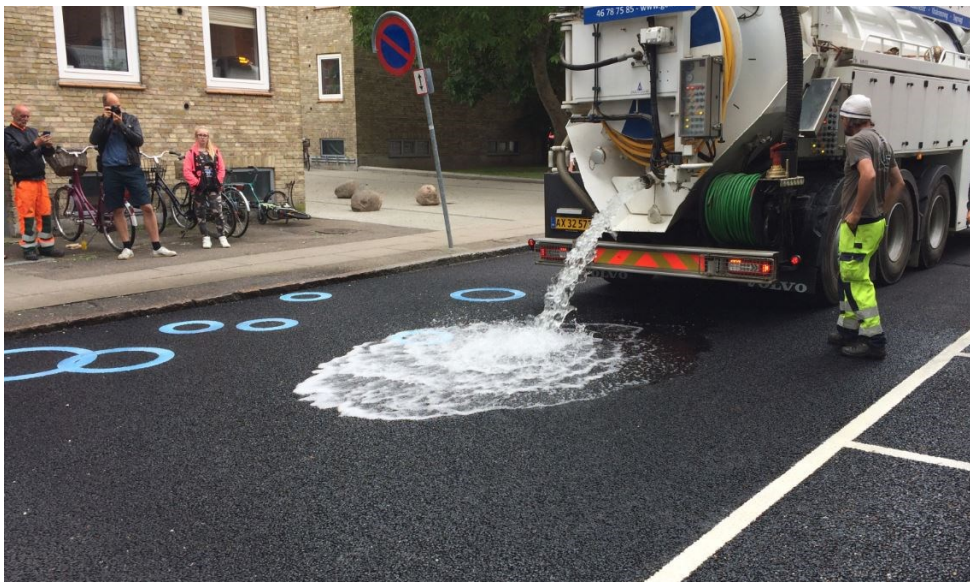
Figur 8.4-3: Demonstrationsforsøg fra AkvaVejens indvielse: Trods fuld vandstråle (af rent vand) fra slamsugerbilens blev alt vandet straks "slugt" af den permeable belægning! De blå cirkler er udsmykning, der symboliserer, at der er tale om en klimatilpasset vej, da løsningen ellers er "usynlig" i det daglige gadebillede
