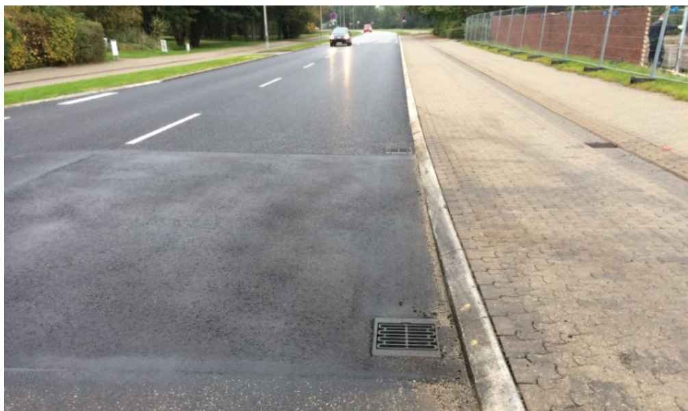
Figur 6.1-3: Testfelt med tilslutningsramper. Nedløbsristen i forgrunden er en "snydebrønd" med forbindelse til den bagvedliggende nedløbsbrønd, til sikring af afvanding i korrekt højde.
