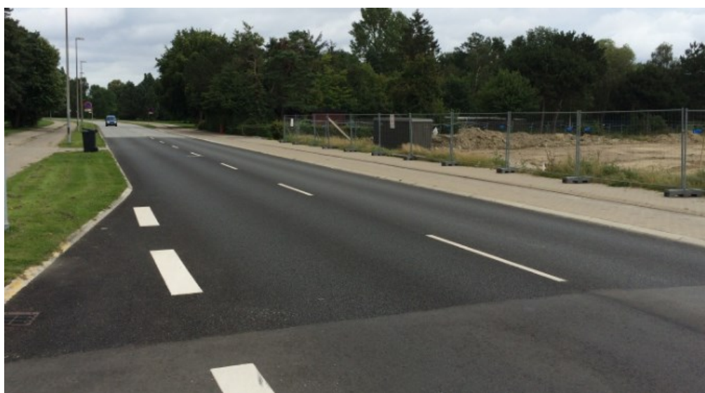
Figur 6.2-4: Efter 10 måneders trafikpåvirkning ser belægningen fortsat fin ud. De lidt lysere spor i køresporene skyldes ikke sporkøring eller "fedme", men er et udtryk for den begyndende afslidning af bitumenhinderne på toppen af stenene i overfladen – et fænomen, som er kendt fra alle asfaltslidlag, men som normalt forekommer noget tidligere end her, hvor der er anvendt en særlig robust polymermodificeret bitumensammensætning.
