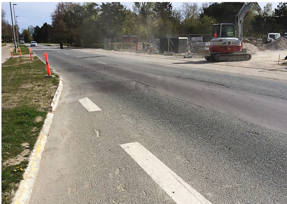
Figur 6.2-5: Teststrækningen er et godt eksempel på de problemer, som hurtigt kan opstå ved en ellers nøje planlagt forsøgsstrækning: På den gamle Irma-grund langs Korsdalsvej skulle bygges nye attraktive boliger. Allerede ultimo 2016, umiddelbart efter de sidste målinger i Klimavej-projektet var gennemført, blev teststrækningen udsat for omfattende opgravninger for forsyningsledninger. Endvidere opstod en del byggeplads trafikskrammer, ligesom belægningens porer i væsentligt omfang blev fyldt med fastkørt sand/jord fra byggepladsen. Det vurderes derfor desværre ikke realistisk at foretage fremtidige, opfølgende målinger (ud over dette projekt) på belægningen.
