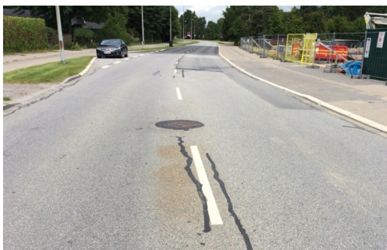
Figur 7.3-7: Den gamle, tætgraderede AB t belægning er ved rullemodstandsmålingerne anvendt som reference.
