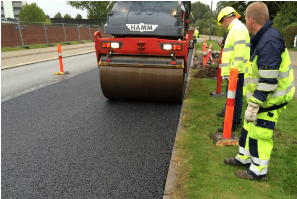
Figur 6.2-1: Udlægning af multifunktionel drænasfalt på Korsdalsvej i Rødovre 06-10-2015.
