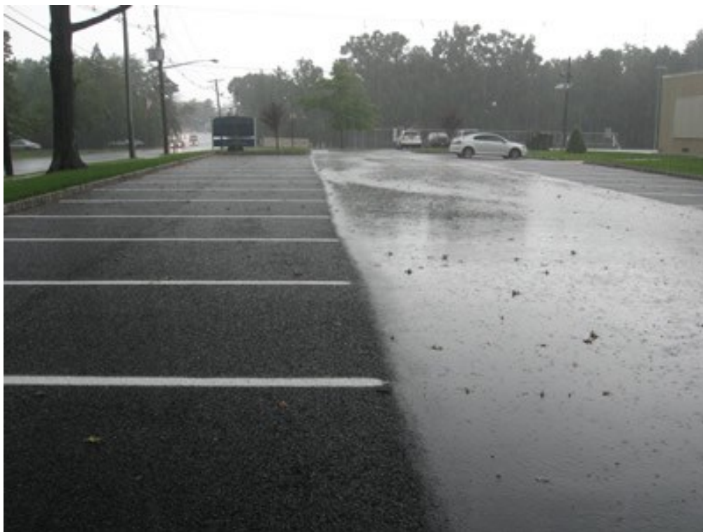
Figur 10.1-1: Eksempel på forskellen i overfladestrukturen for drænasfalt (t.v.) og tætgraderet asfalt (t.h.)
