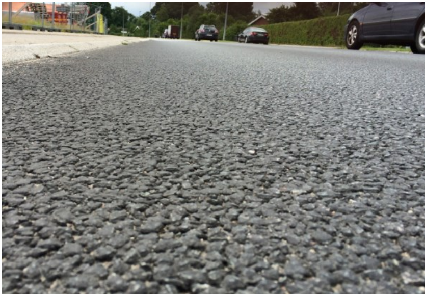
Figur 7.3-3: Nærbillede af drænasfalten på Korsdalsvej, som hovedsageligt består af 8/11 mm granitskærver. Belægningen har en overflade som er mere hulrumrig og med grovere tekstur end de specielle, mere finkornede COOEE belægningstyper, som er optimeret for lav rullemodstand, men til gengæld har lav dræningsevne.
