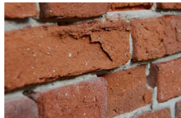
Figur 26 Nogle gange afslører murværket, at der er højt saltindhold i murværksmaterialerne, andre gange er det ikke synligt.
