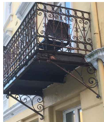
Figur 6 Altan med altanplade af stål og bærende udkragede stålprofiler indspændt i etageadskillelsen. Skråafstivningen under stålbjælkerne understøtter formentlig de udkragede stålbjælker ved forkanten, men ofte er skråafstivninger kun til pynt/dekoration. Billedet er fra Bergen, Norge. Altaner blev også udført således i Danmark i perioden 1890-1910, typisk på de finere, murede huse. De fleste af disse altaner er i dag udskiftet med nye.
