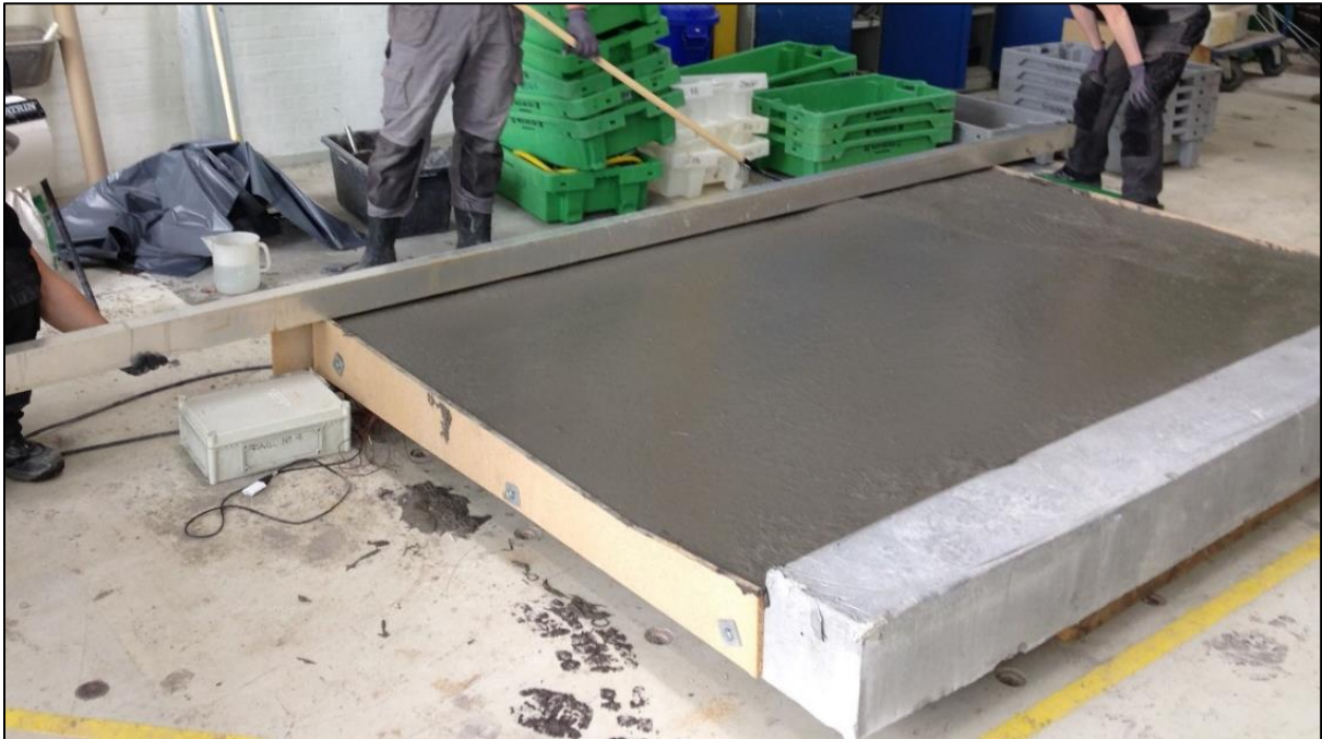
Fig. 5. Billede fra fremstilling af mock-up af brodæk med et toplag af stålfiberarmeret højstyrkebeton.
