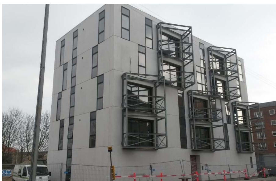
Figur 3.9 Altanerne er opbygget af et metalskelet monteret udvendigt på vægelementerne.
