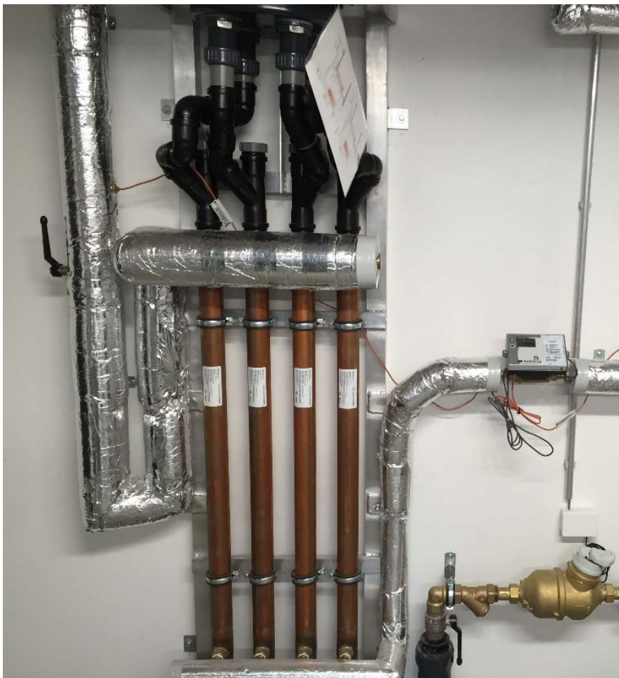
Figur 3.14 Varmegenvinding på det grå spildevand.
