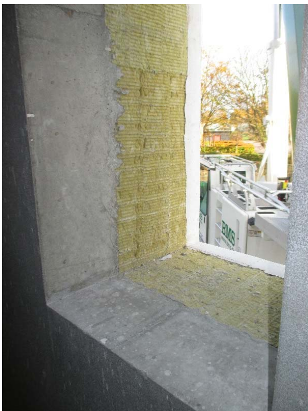
Figur 3.6 Vinduesåbning i et vægelement.
