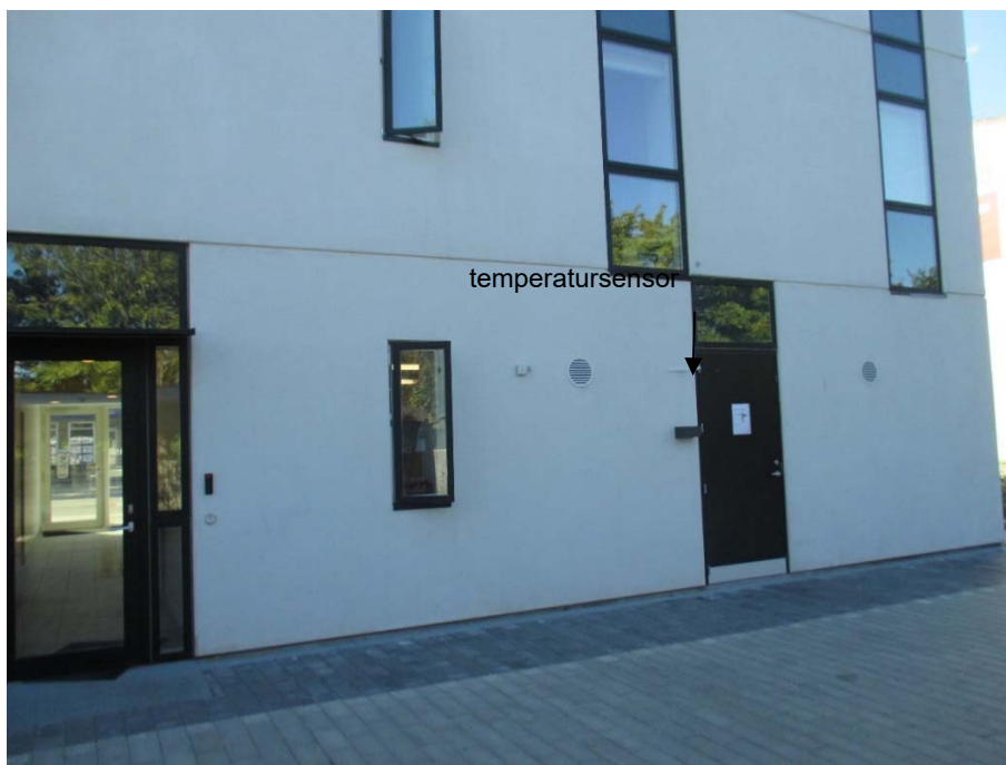
Figur 4.3 Placeringen af udeluft temperatursensoren.
