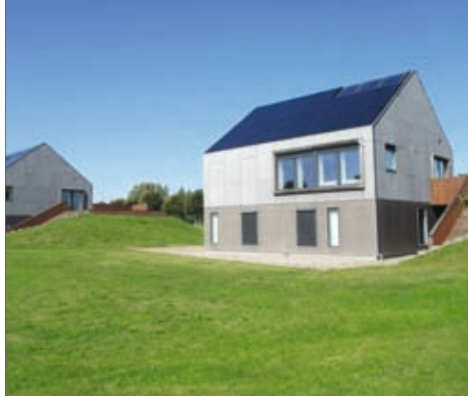
Figur 2. Eksempel på en prosumer: EnergyFlexHouse på Teknologisk Institut, www.energyflexhouse.dk . Takket være et stort solcelleanlæg på henholdsvis 40 og 60 m 2 producerer husene på årsplan lige så meget elektricitet, som de bruger inkl. el til husholdningen og en el-bil. Foto: Søren Østergaard Jensen.
