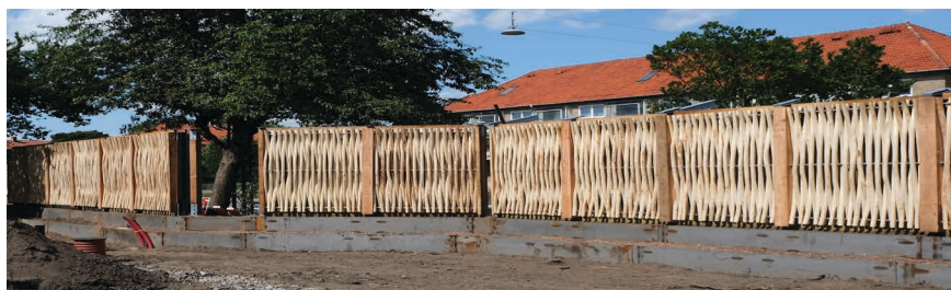
Figur 4. Grøn Klimaskærm under opførelse ved 3B-Folehaven, set fra vejen. Mineralulden er skjult bag pileelementer. Efterfølgende beplantes skærmen.
