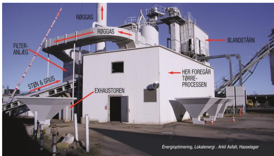
Figur 30 Billede af Arkil asfalt fabrik
