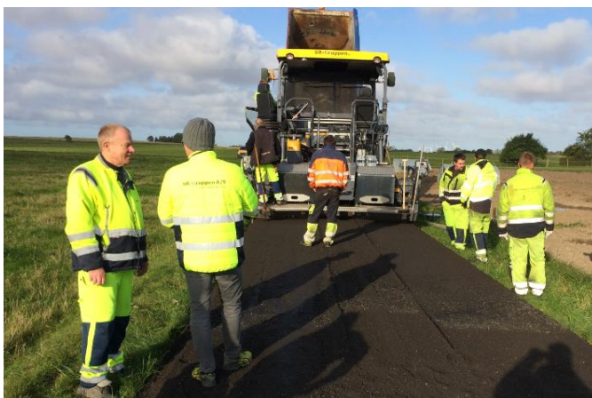
Fig. 7.7: Udlægning af BSM med asfaltudlægger
