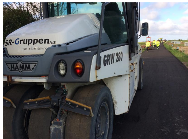
Fig. 7.8 og 7.9: Komprimering med glatvalset vibrationstromle og tung gummihjulstromle ved udlægning på Vådagervej.
