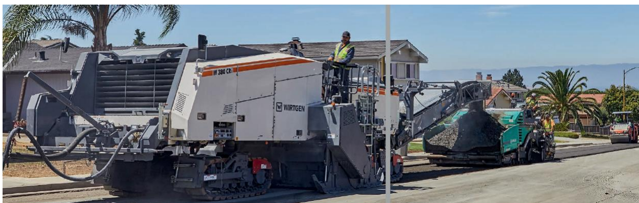
Fig 2.8: In-situ recycling (Kilde: Wirtgen)
