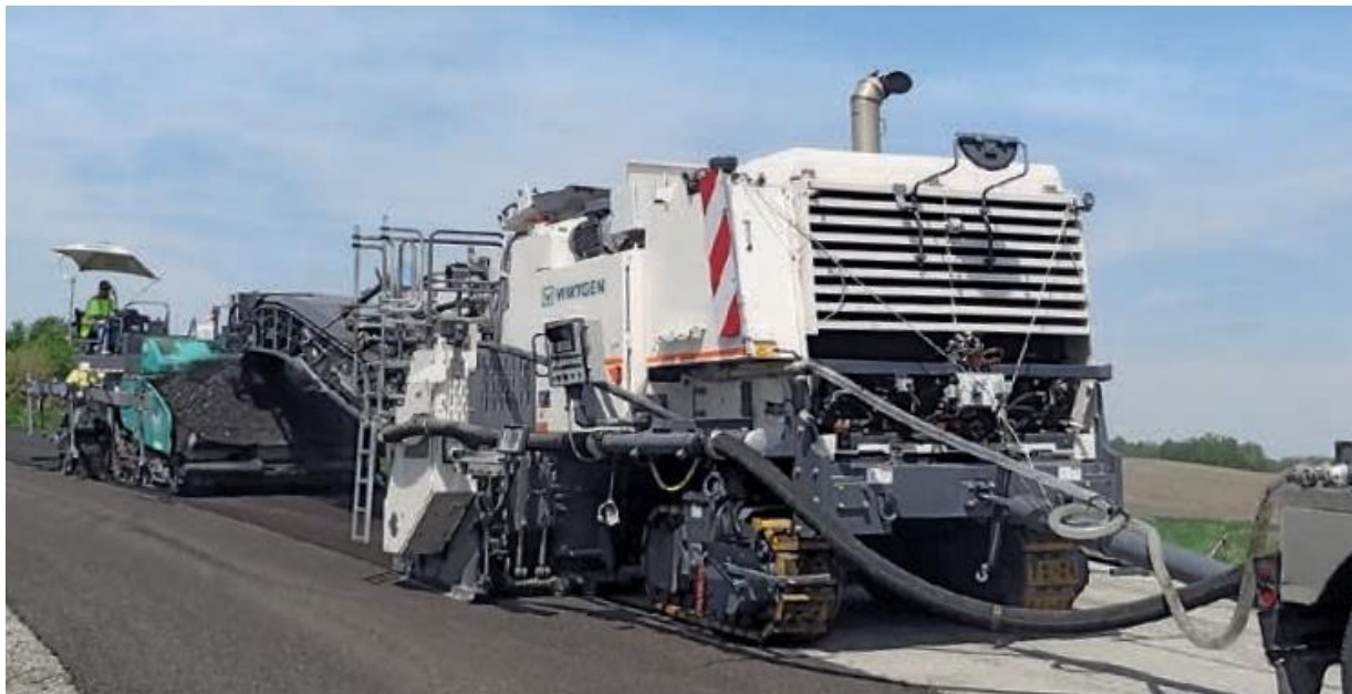
Fig. 2.3: Eksempel på in-situ fremstilling af BSM med recycler: Den gamle asfalt fræses op og stabiliseres med skumbitumen, hvorefter den fødes til en konventionel asfaltudlægger. (Kilde: Wirtgen)
