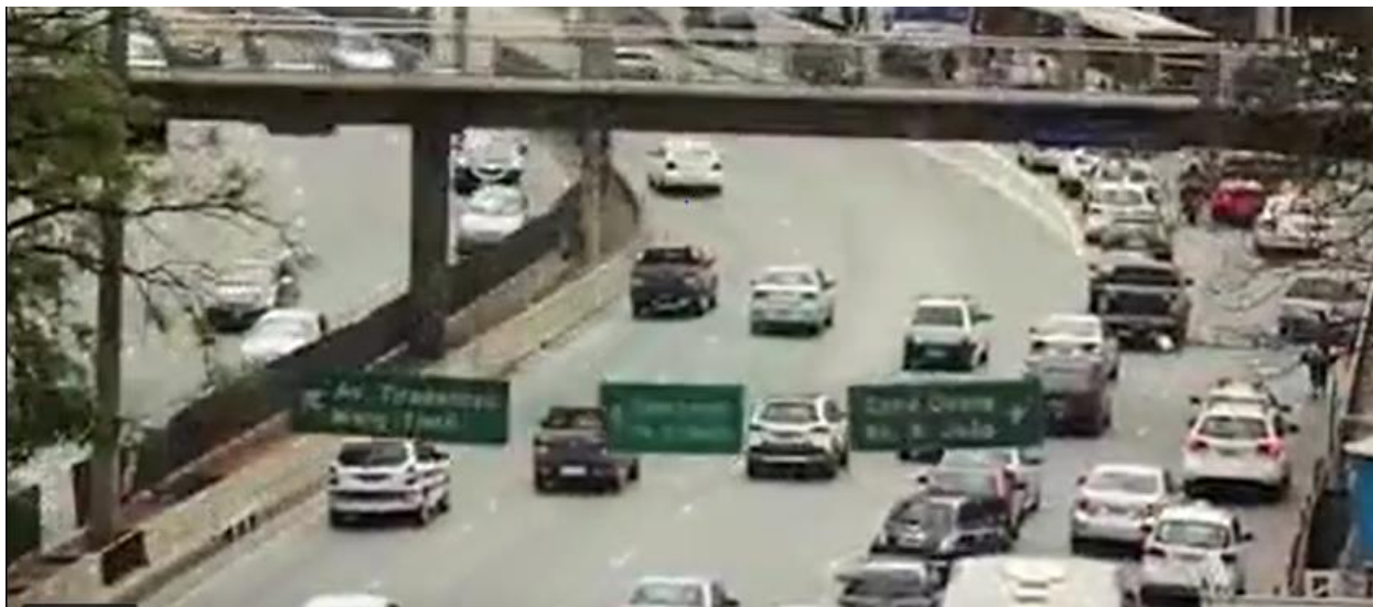
Fig. 2.9: Ayrton Senna Highway, Sao Paolo, Brasilien (Kilde YouTube/Wirtgen)
