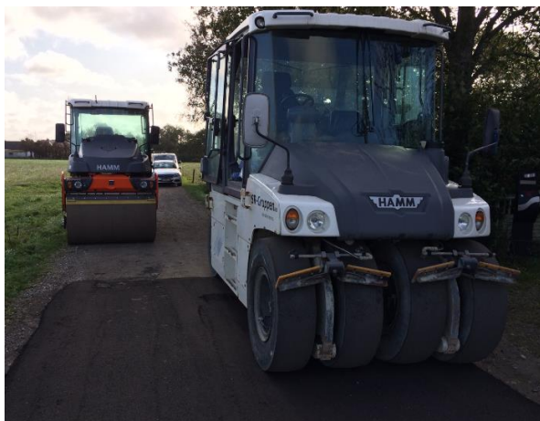
Fig. 7.8 og 7.9: Komprimering med glatvalset vibrationstromle og tung gummihjulstromle ved udlægning på Vådagervej.
