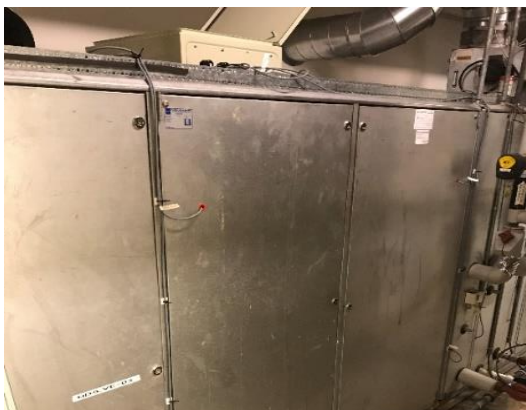
Figur 7.1.12 Temperatur sensorer monteret på køkkenanlægget i IDA huset.
