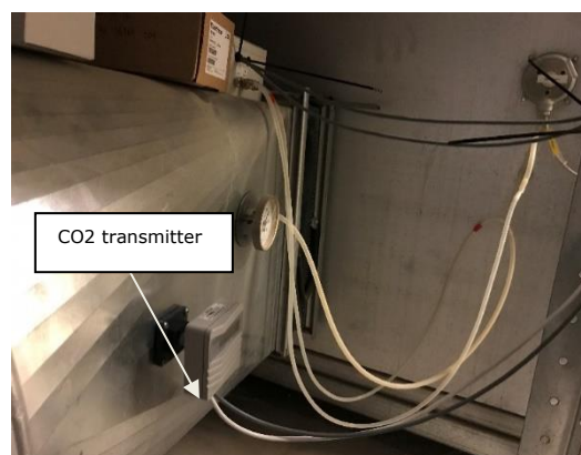
Figur 7.1.11 CO2 føler monteret i udsugningskanalen efter aggregat og udsugningsfilter.
