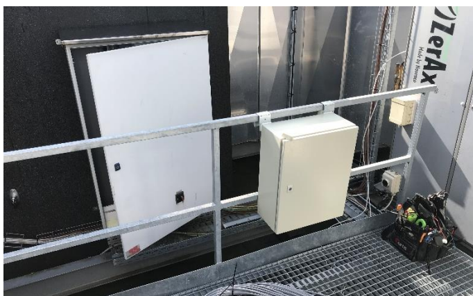
Figur 7.2.3 Billedet viser de to elskabe som indeholder Raspberry Pi's til måleopstillingen.
