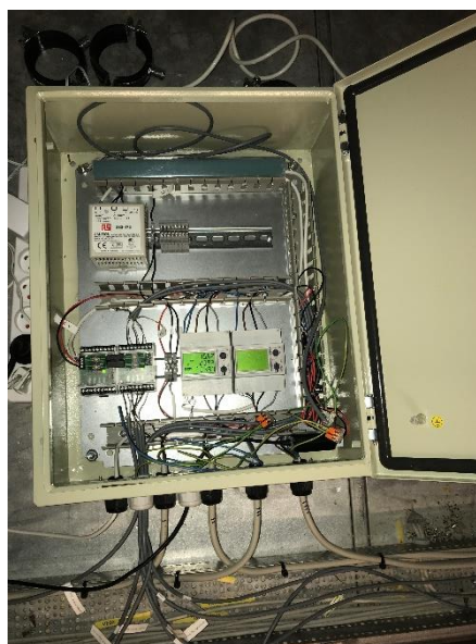
Figur 7.1.7 Vægkasse med DIN skinne og monterede komponenter.
