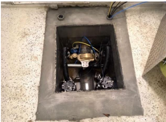
Figur 8.5. Eksempel på et kompakt lukket anlæg placeret i kældergulv.
