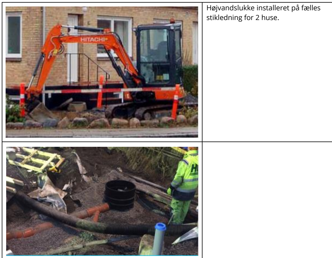
Figur 7.3. Eksempel på fælles højvandslukke til to parceller.
