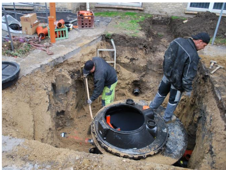
Figur 8.6. Eksempel på et præfabrikeret lukket anlæg placeret i en brønd uden for bygning.
