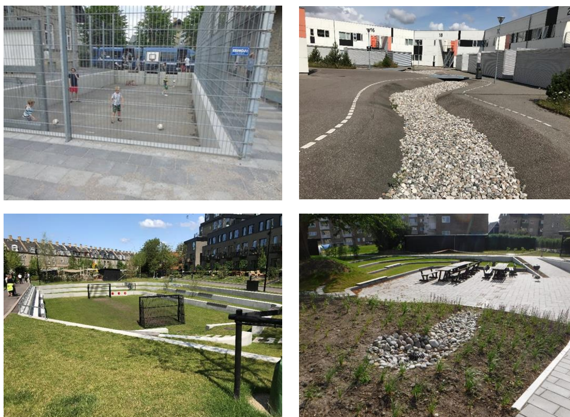
Figur 5.8. Eksempler på magasinering i regnvandsbassiner, hvor der ikke er meget plads.
