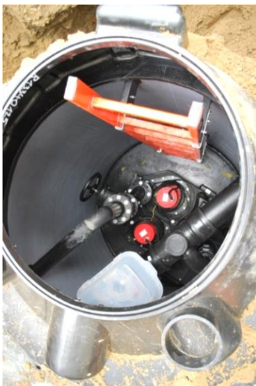
Figur 8.6. Eksempel på et præfabrikeret lukket anlæg placeret i en brønd uden for bygning.
