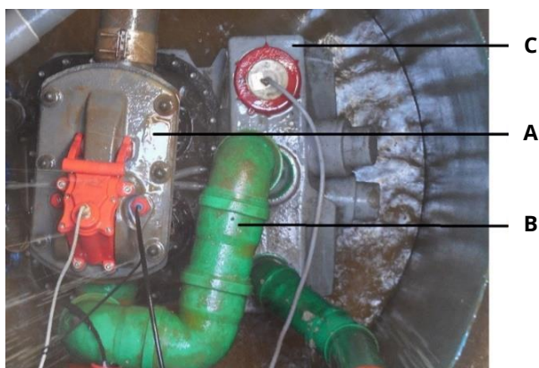
Figur 9.2. By-pass brønden. A=Højvandslukket, B=Overløbsrøret, C=Pumpen og pumpebrønden.
