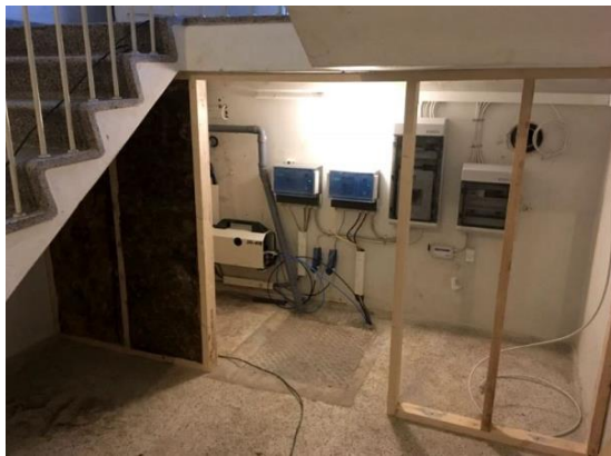
Figur 8.5. Eksempel på et kompakt lukket anlæg placeret i kældergulv.
