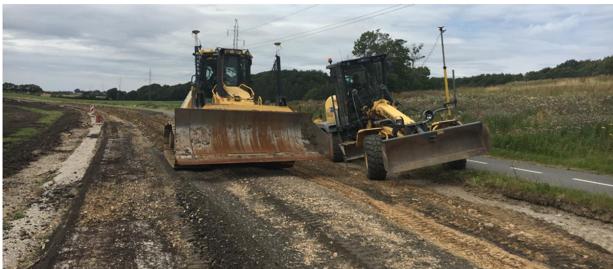
Fig. 3.3: Den eksisterende makadam-belægning blev fordelt ud i den nye udvidede vejbredde inden stabilisering i 8 m bredde.
