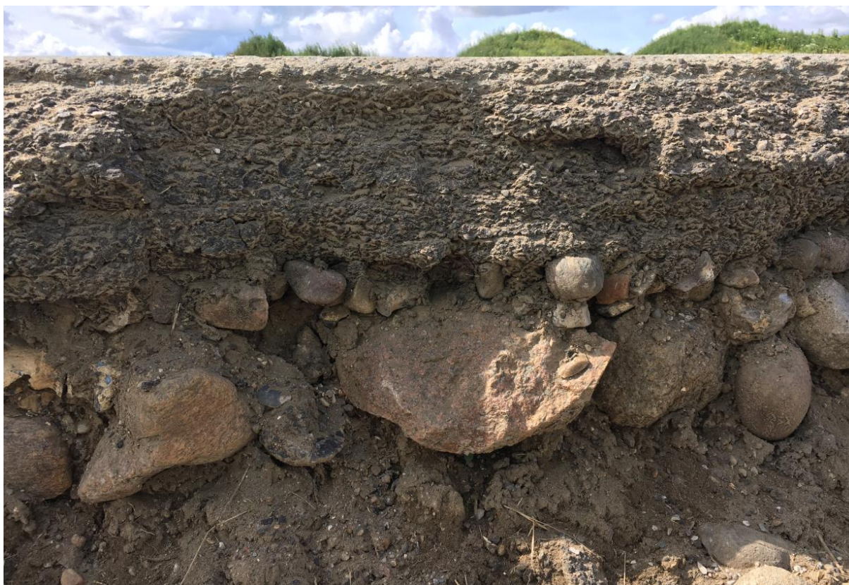
Fig. 3.1: Den gamle opbygning bestod af ca. 15 cm asfalt og 30 cm Makadam med enkelte helt op til 30 cm store sten. Den underliggende råjord bestod i det væsentlige af ler.
