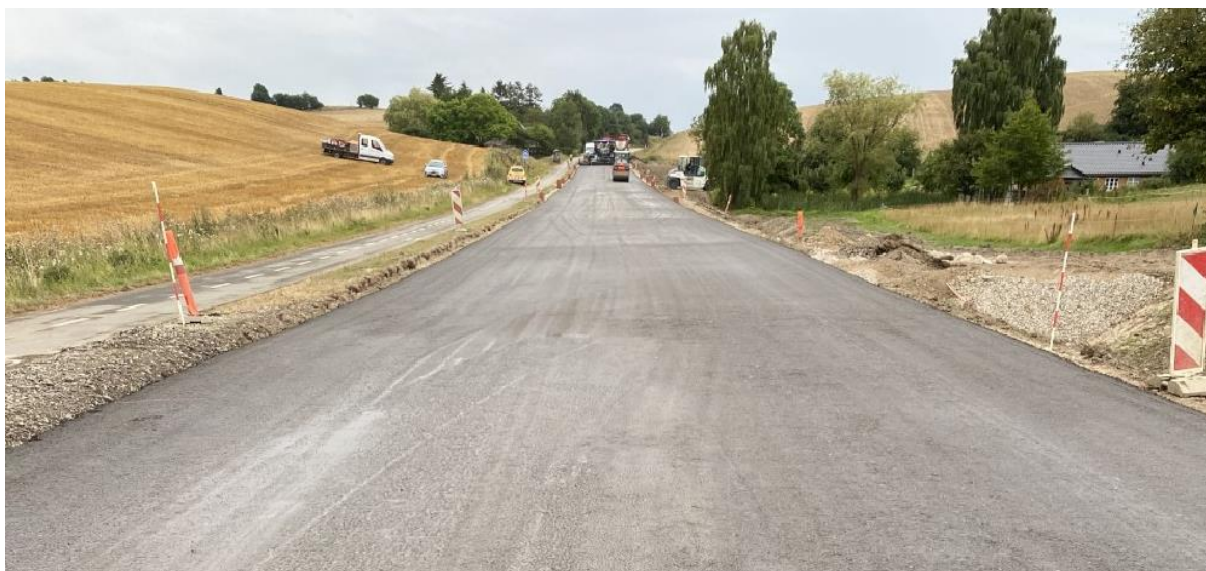
Fig. 3.11: Efter den afsluttende tromling (billedet) var BSM-belægningen klar til det afsluttende slidlag, som består af 5 cm (125 kg/m 2 ) SMA 11 med polymermodificeret bitumen for at give den nye belægning ekstra lang levetid og revnemodstand. SMA-laget er udlagt i 7 meters bredde.
