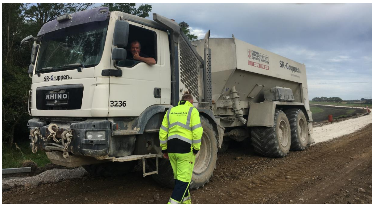
Fig. 3.4: Udspredning af hydratkalk som forberedelse til kalkstabilisering af det nye bærelag.
