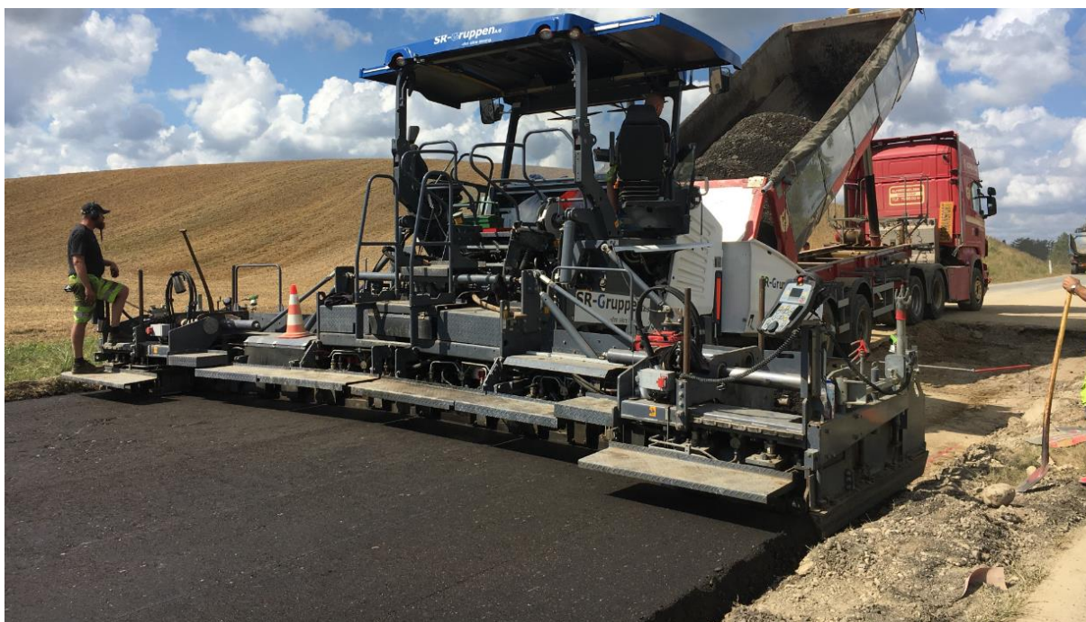
Fig. 3.6: Udlægning af 15 cm BSM bundlag i 8 meters bredde.
