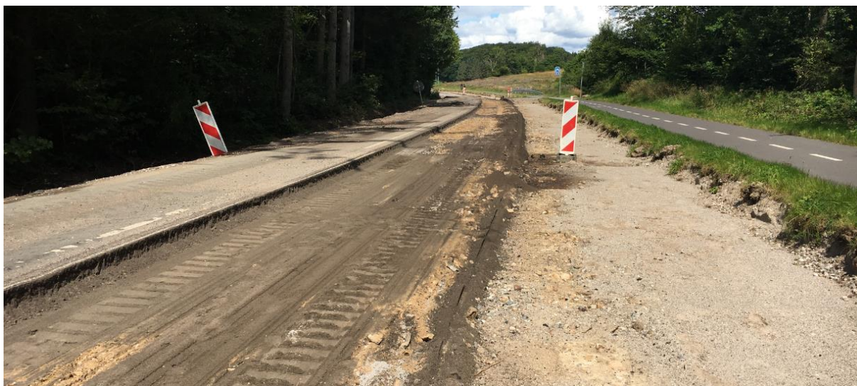
Fig. 3.2: Affræsning af den eksisterende belægning.
