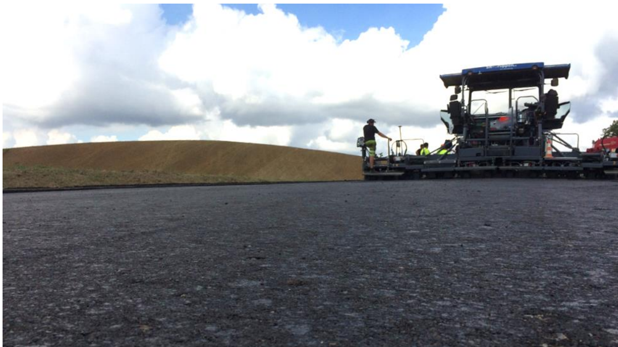
Fig. 3.10: Ensartet og jævn overflade. Det ses, at BSM-materialet indeholder lidt grove sten, men er fint homogent. Bredden af det øverste BSM-lag er 7,70 meter.
