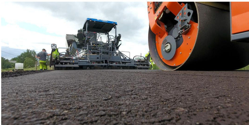
Fig. 7.1: BSM-laget blev udlagt med asfaltudlægger med højkomprimeringsstrygejern og efterfølgende effektivt komprimeret med såvel glatvalset vibrationstromle som tung gummihjulstromle for at sikre en effektiv komprimering i hele lagets dybde og bredde.
