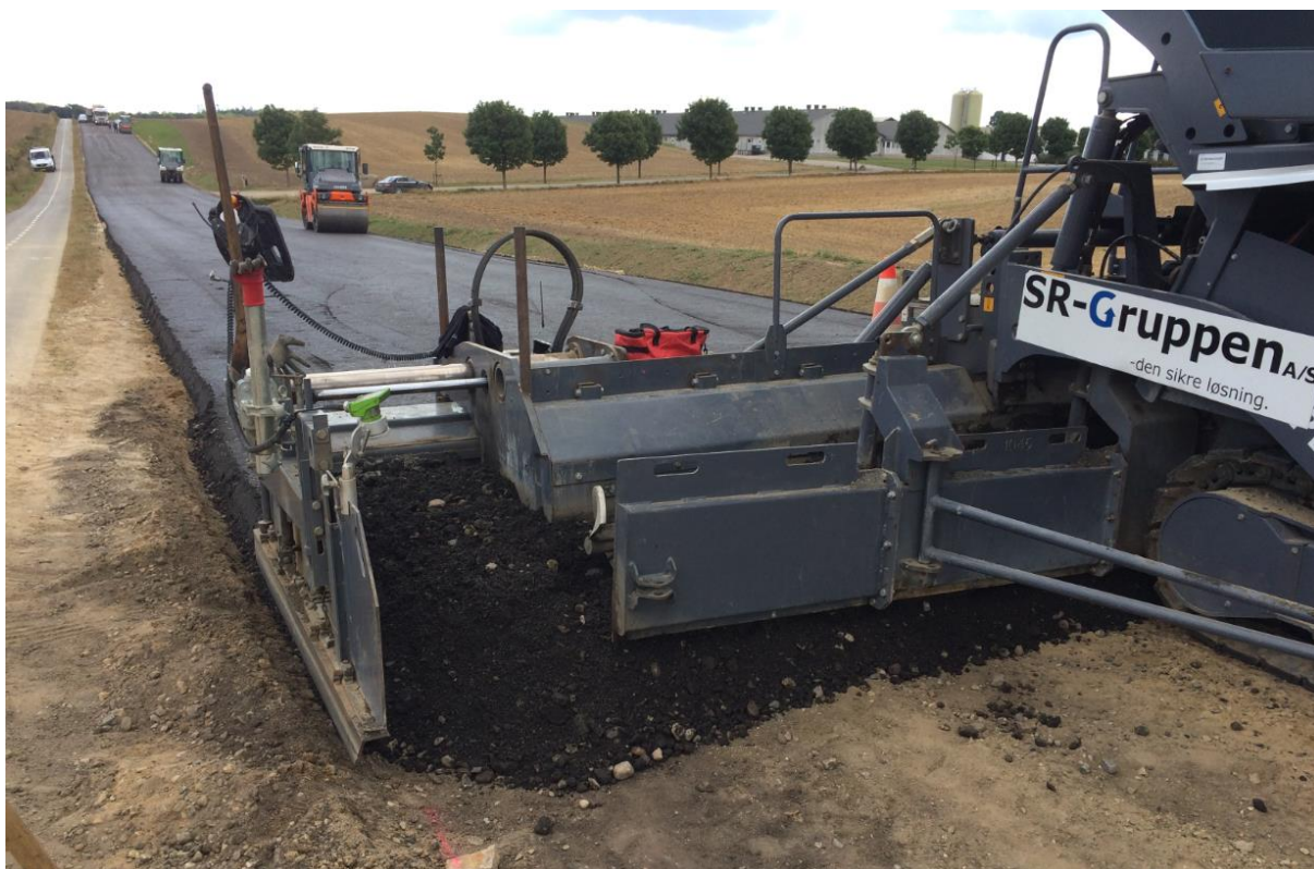
Fig. 3.9: BSM-belægningen blev efter udlægningen komprimeret effektivt med såvel tung glatvalset vibrationstromle som tung gummihjulstromle.
