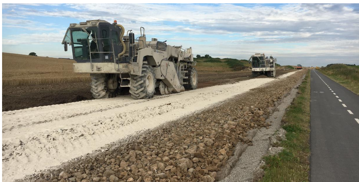
Fig. 3.5: Gennemfræsning og kalkstabilisering i 50 cm dybde. Bemærk de grove makadamskærver i forgrunden af billedet.
