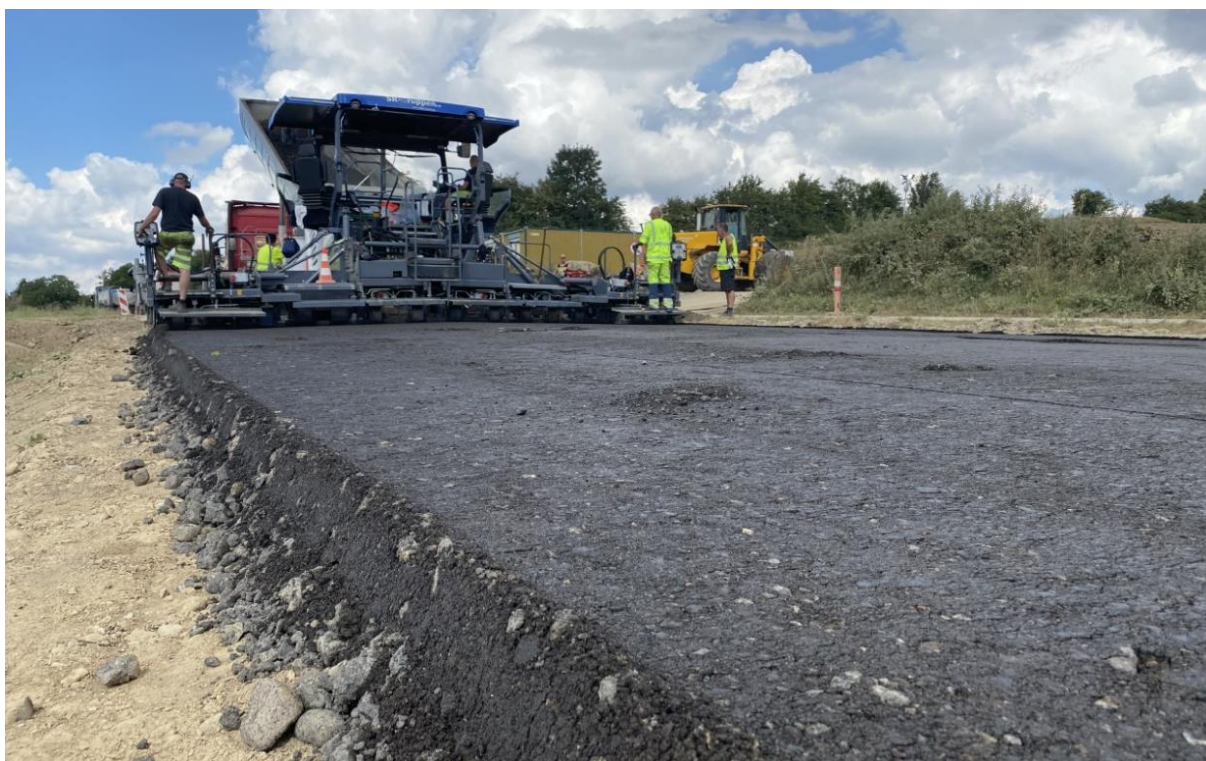
Fig. 3.8: BSM-belægningen blev udlagt i to lag, i alt ca. 25 cm samlet tykkelse (her ses første lag).
