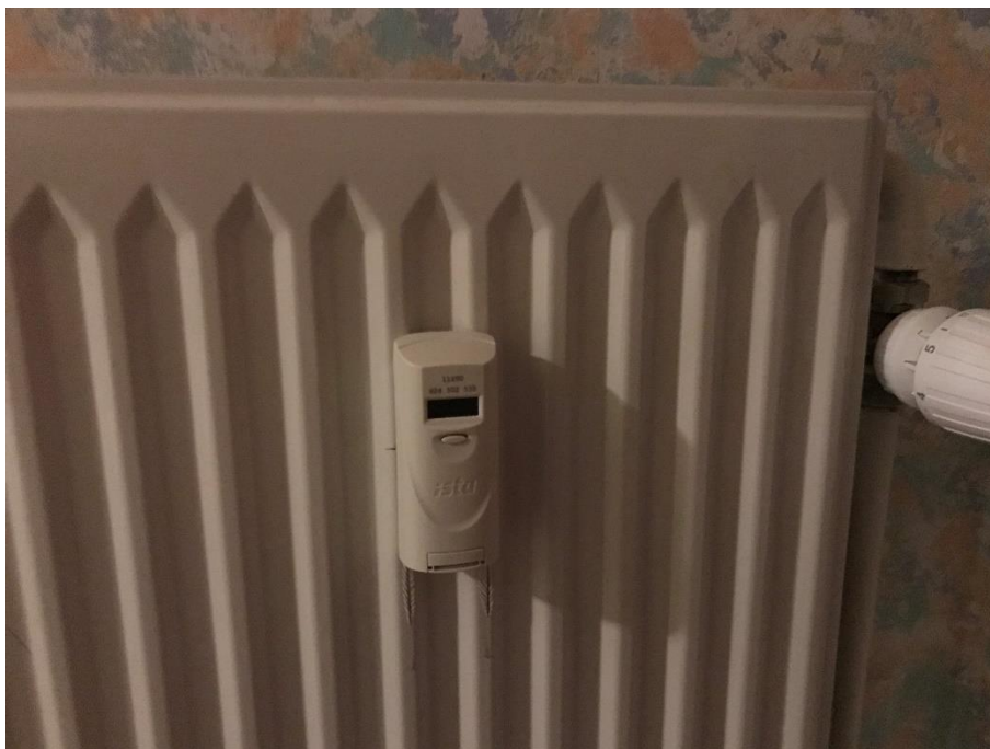
Figur 6.23. Varmefordelingsmåler på en gammel Thor radiator
