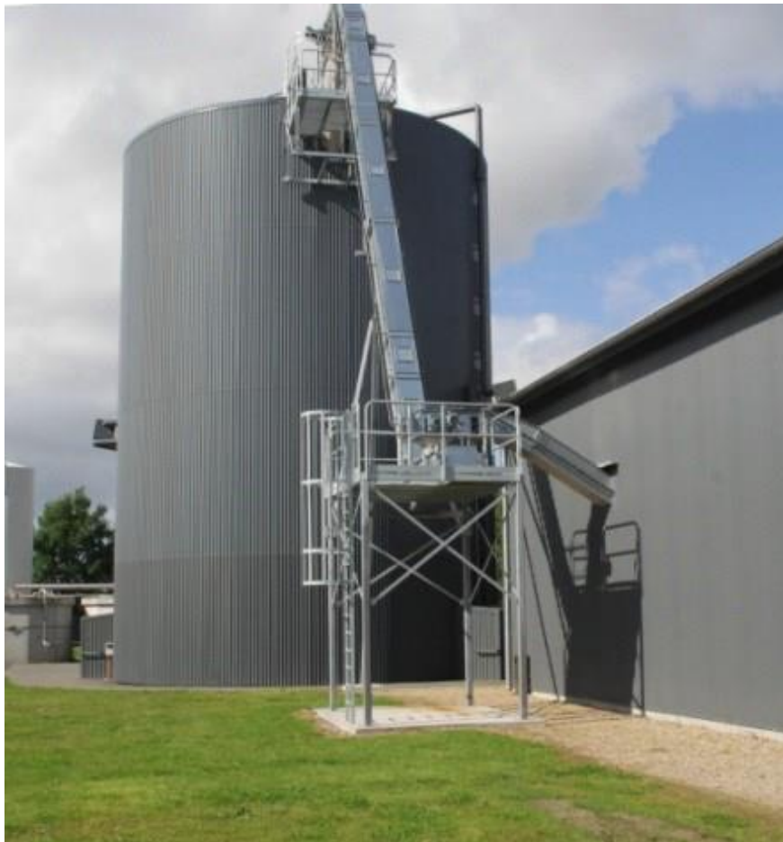
Figur 7. Bånd og snegl til indfødnings, Aarhus Universitet
