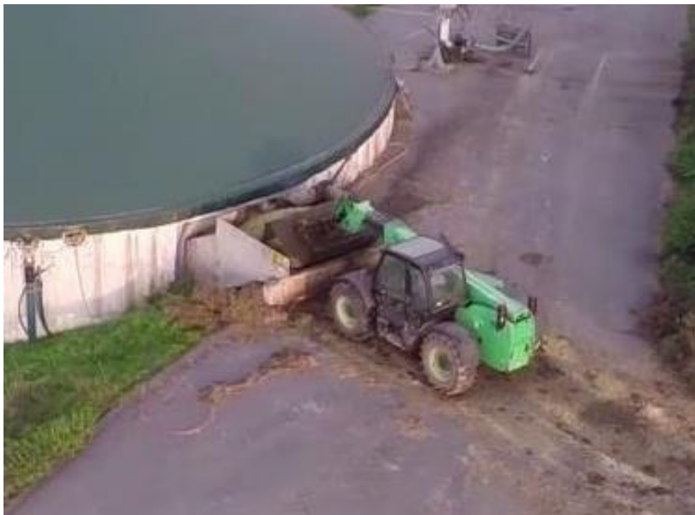
Figur 4. Biomassen skubbes ind via en tragt på ydersiden af reaktoren på et Sauter anlæg i Tyskland.
