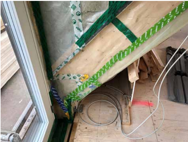
Figur 6.1 – Eksempel på etableret tæthedsplan med tape fra forskellige leverandører.
