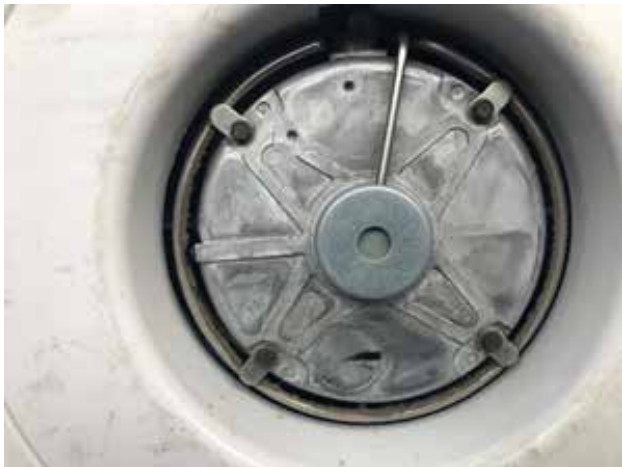
Figur 5.2 – Eksempel på snavset blæser.
