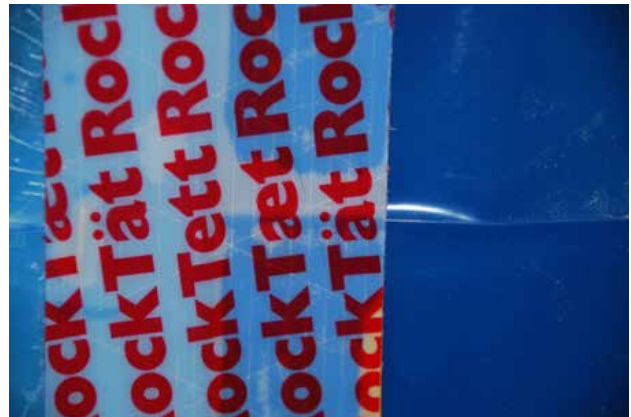
Figur 6.2 – Mindre utæthed af membran pga. folder ved tapet samling.
