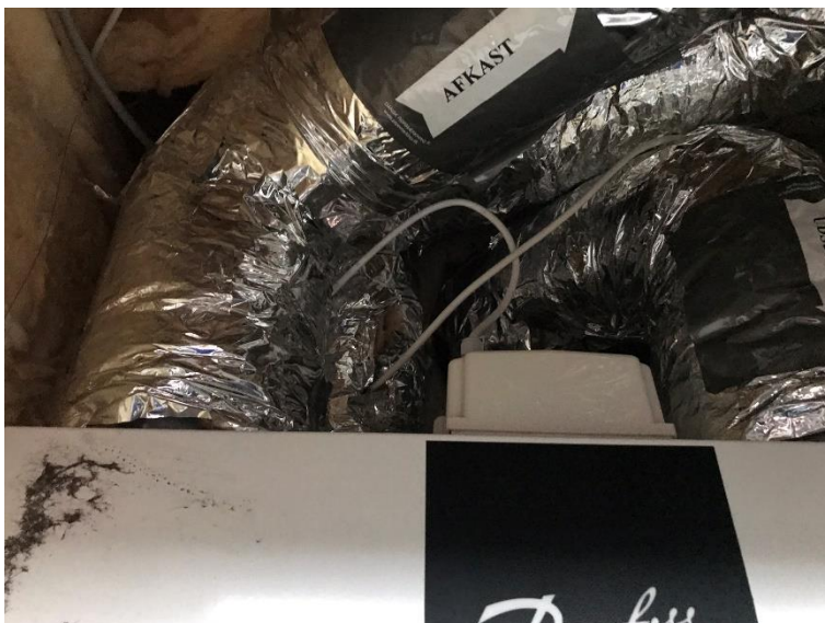
Figur 7.8. Decentralt ventilationsanlæg til etagebolig
