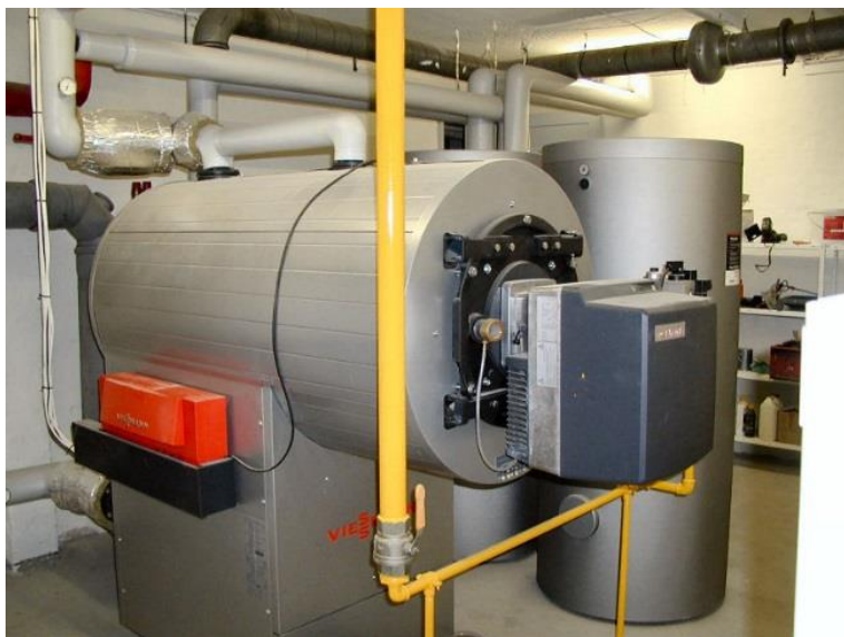
Figur 7.2. Kondenserende gaskedel
