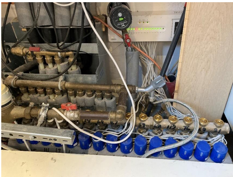
Figur 6.2 Gulvvarmeanlæg
