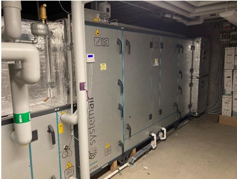
Figur 7.7. Centralt ventilationsanlæg til kontorbygning
