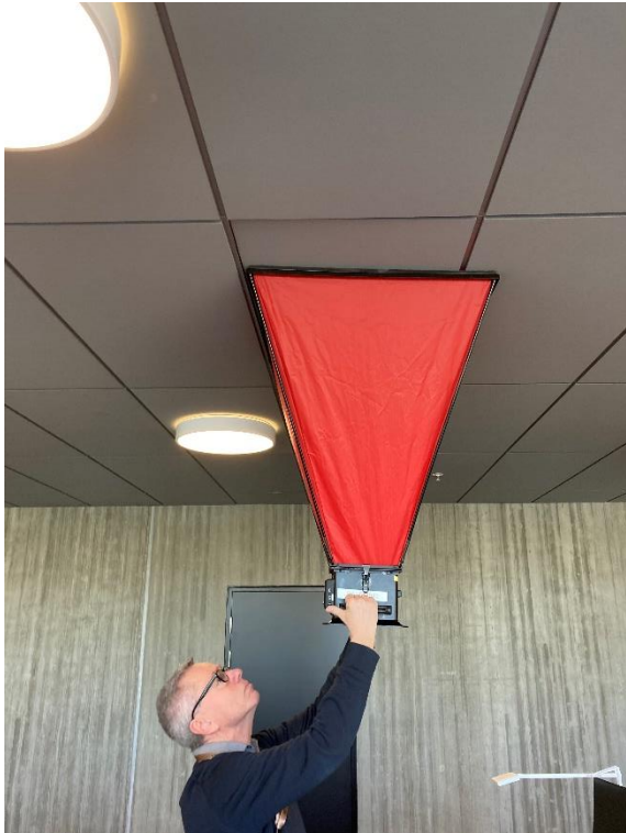
Figur 7.14 Måling med håndholdt måltragt
