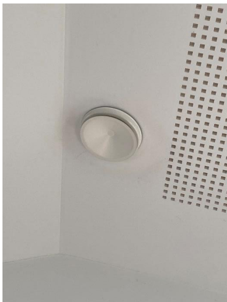
Figur 6.9. Indblæsningsarmatur
