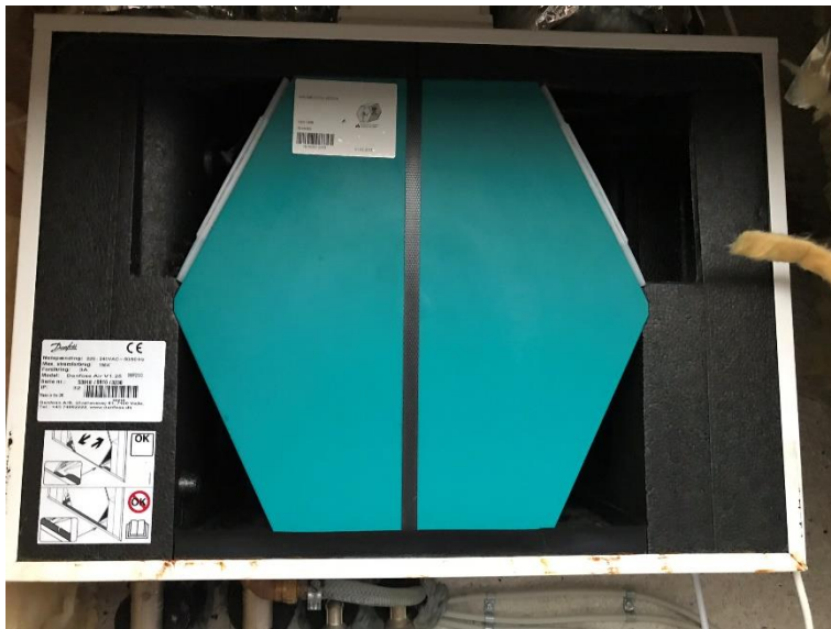
Figur 7.9. Decentralt ventilationsanlæg til etagebolig (samme anlæg som i figur 7.5)
