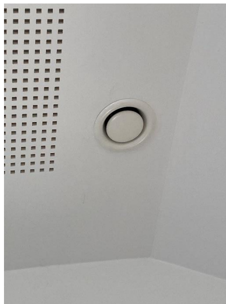
Figur 6.10. Udsugningsarmatur
