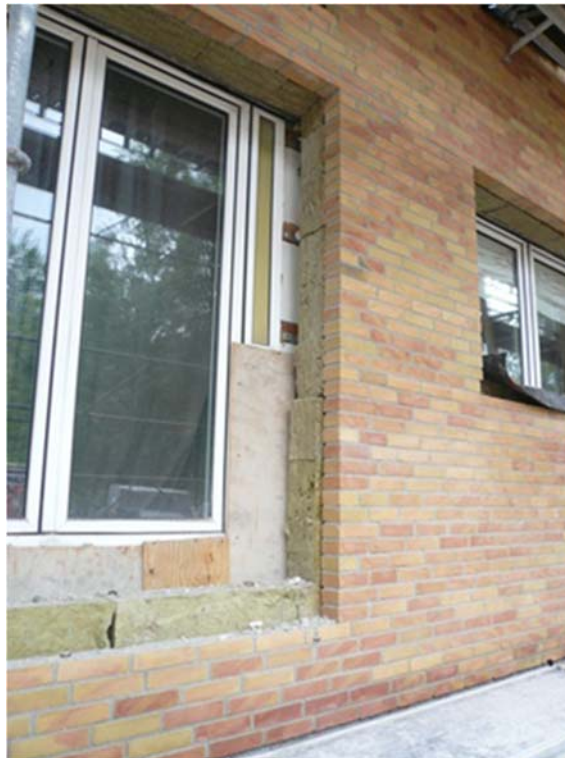
Figur 3.5: Ny isolering af klimaskærmen samt gamle vinduer.
