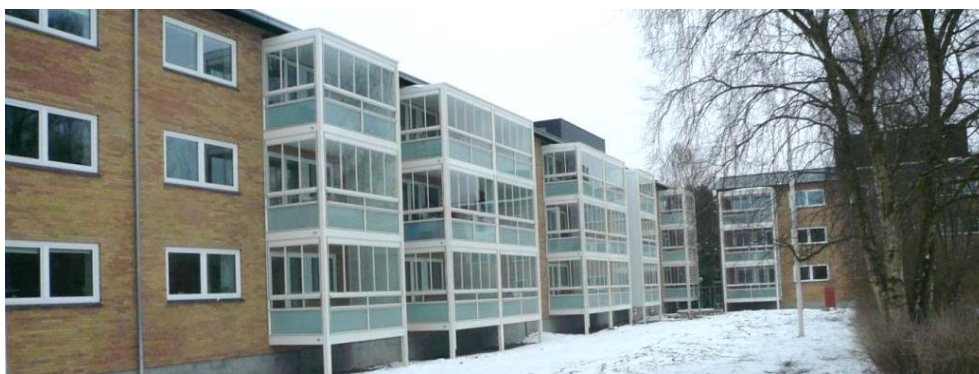
Figur 2.12: Den nye murede facade på to af boligblokkene efter reoveringen, mod haven.
