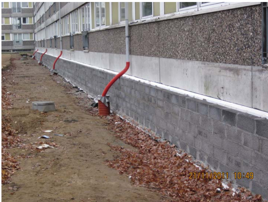
Figur 3.3: Kælderydervægge færdiggjort.
