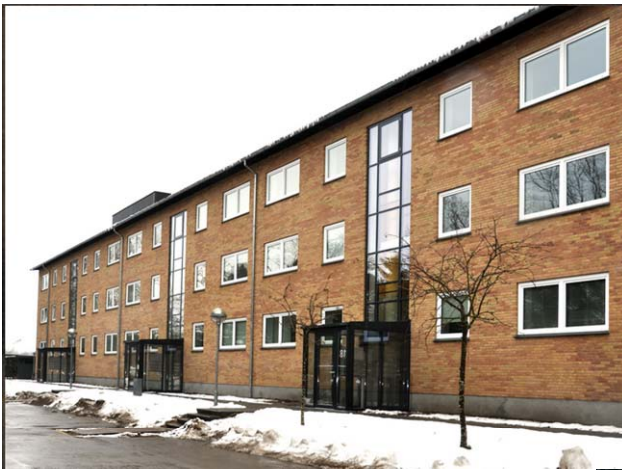
Figur A.1. Forsiden af blok B efter renovering.
