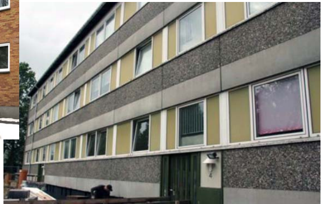
Figur A.2. Bagsiden af blok B før renoveringen.
