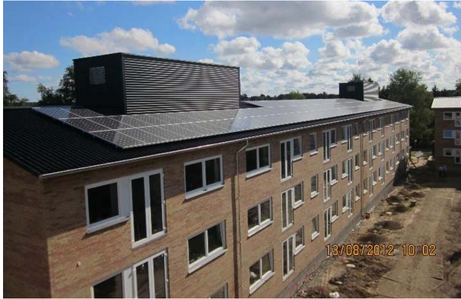
Figur 4.5: PV- og ventilationssystem på taget af blok B.
