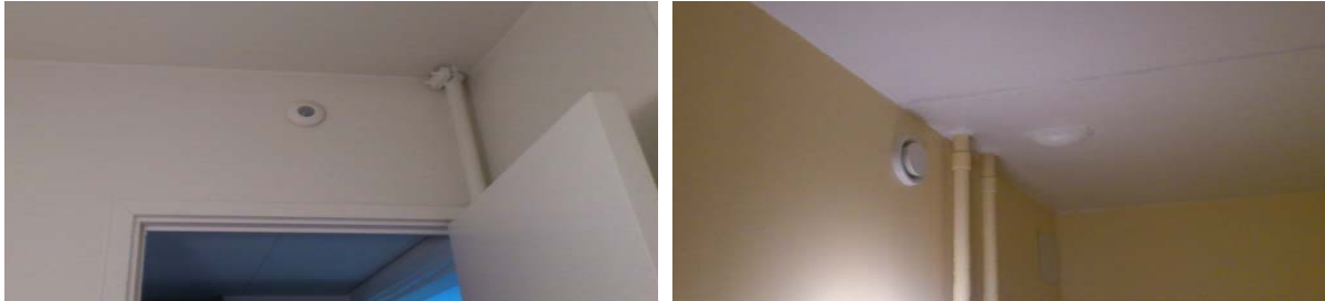
Figur 4.3: Eksempel på en PIR tilstedeværelsesføler (venstre) og en udsugningsventil i badeværelset (højre).
