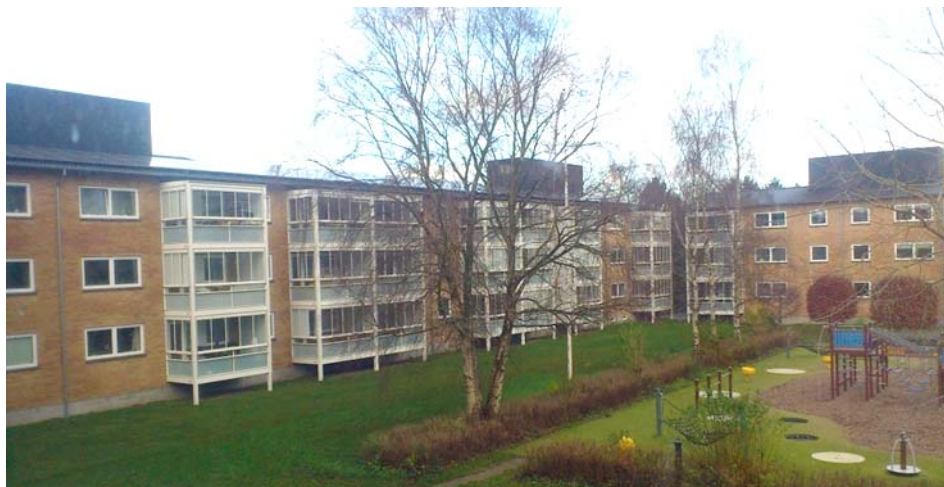
Figur 4.2: Ventilationsaggregater er anbragt i ventilationshuse på bygningernes tage.
