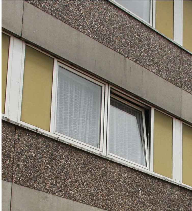
Figur 3.10: Gamle vinduer med 2-lags termoruder.
