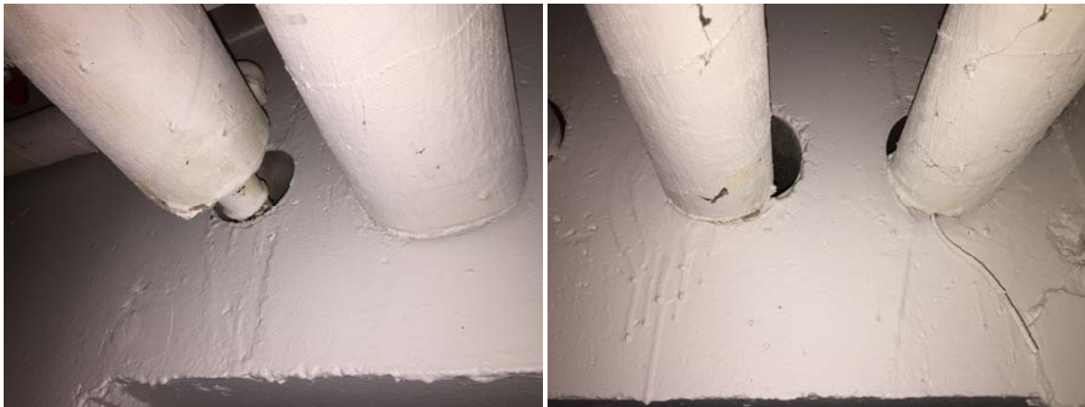
Figur 4.1: Uisolerede gennemføringer af varmerør i kælderen. Billedet er ikke fra Traneparken, men fra en lignende bygning, hvor varmerør er ført ligesom i Traneparken.
