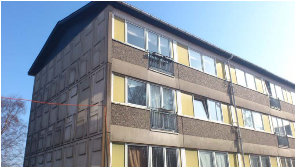
Figur 2.1: Boligblok med nedslidte facader før renovering, mod have.
