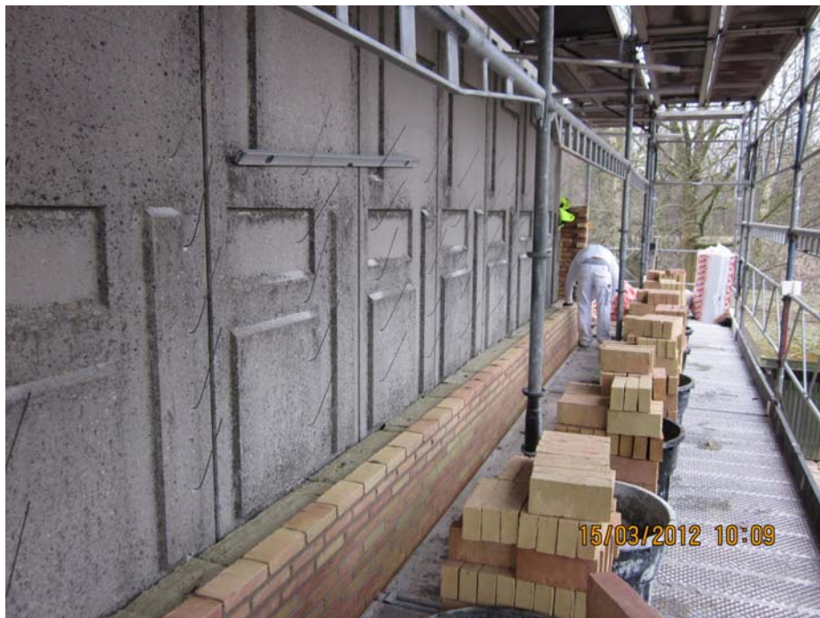
Figur 3.1: Efterisolering og opmuring af gavl.
