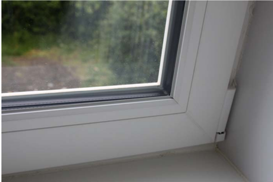
Figur 3.13: Nederste hjørne af et vindue med 3-lags lavenergirisude.
