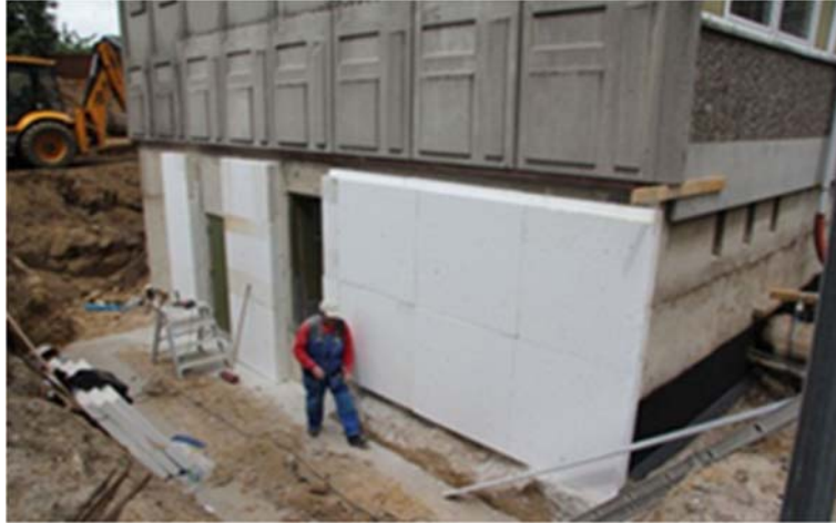
Figur 3.2: Efterisolering af kælderydervæg.
