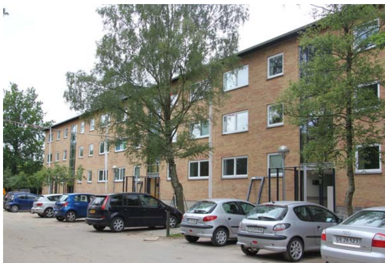
Figur 2.11: Den nye murede facade på én af boligblokkene efter reoveringen, mod parkering.
