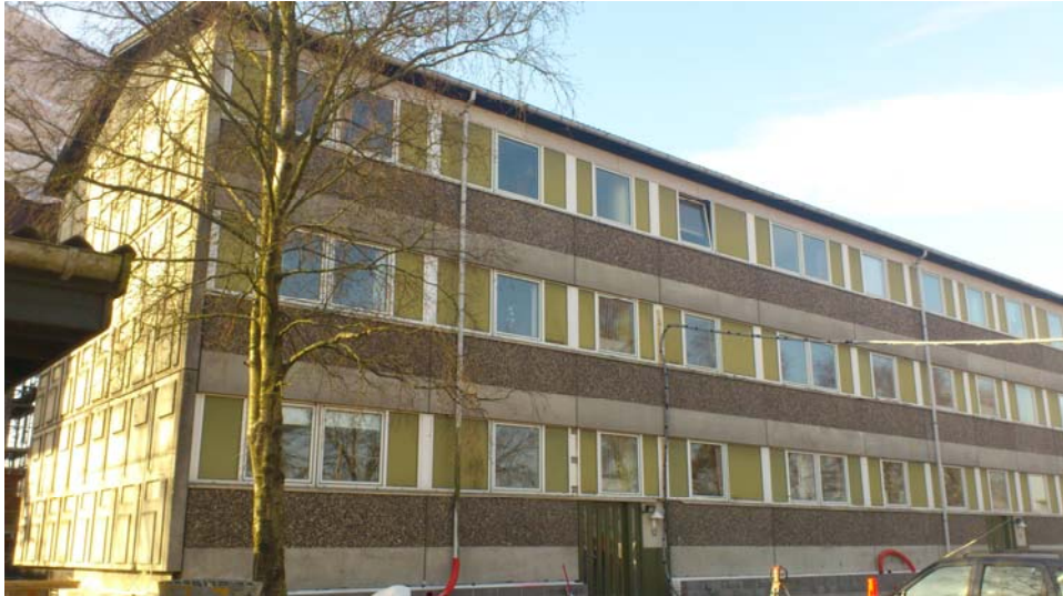
Figur 2.2: Boligblok med nedslidte facader før renovering, mod parkering.
