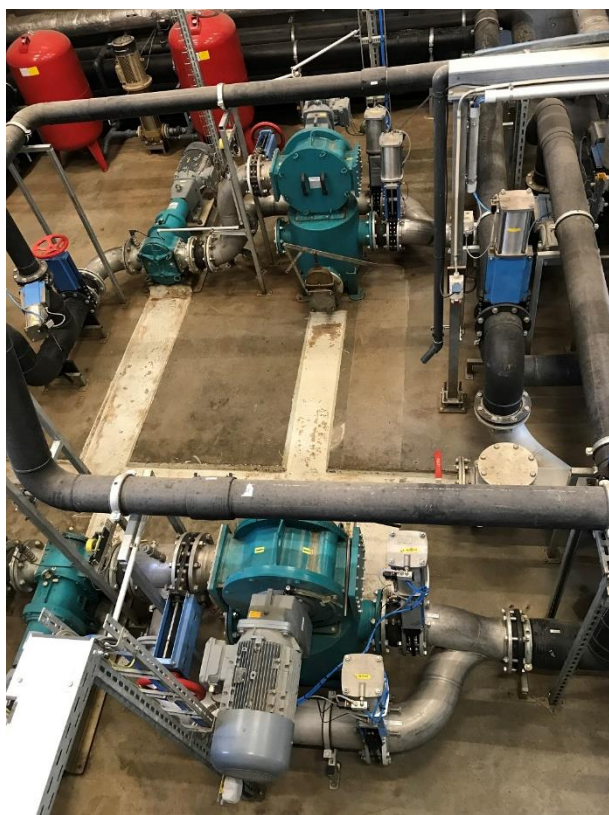
Börger-grindere på indpumpningsstrengene.
