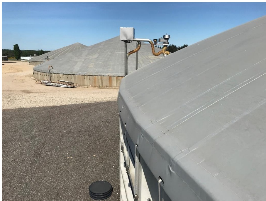
Thorsen Biogas. Forrest ses reaktor 1 og derefter reaktor 2, efterlager uden opvarmning og endelig en udleveringstank uden overdækning.
