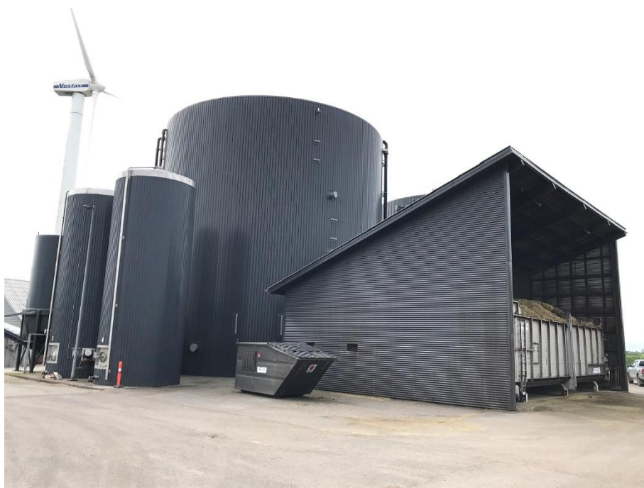
Rybjerg Biogas. Indfødningsanlæg til fast biomasse samt de to parallelforbundne reaktorer i baggrunden.
