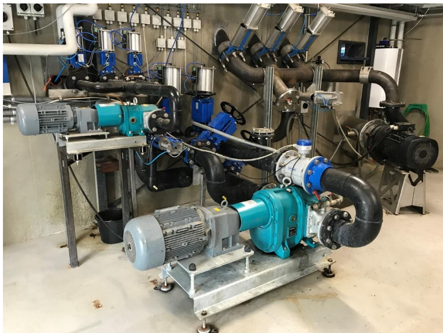
Gasmix-pumper med knive til injektion og omrøring i reaktorer.
