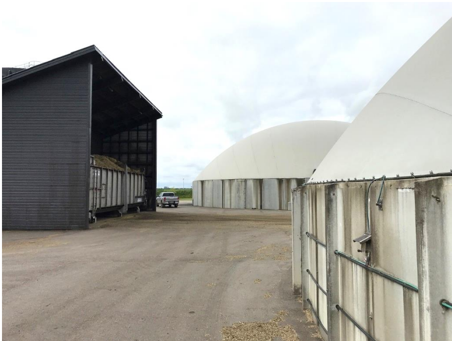
Rybjerg Biogas. T.h. To af de tre efterlagertanke.
