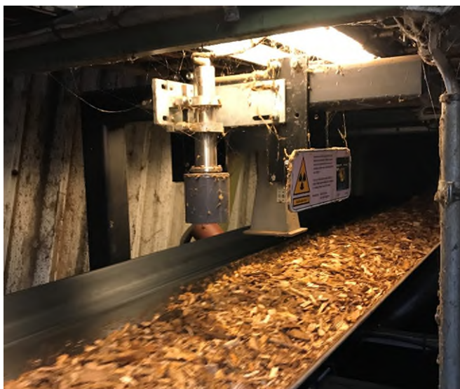
Figur 1. Eksempel på in-line målesystem: Udstyr (her baseret på MW) er placeret på transportbåndet umiddelbart før kedlerne.
