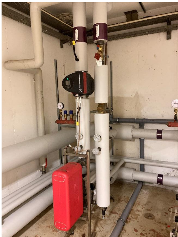
Figur 7.1. Fjernvarmeanlæg med veksler
