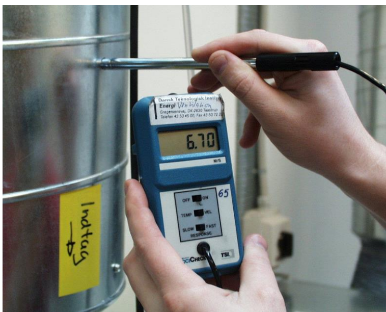
Figur 6.7 Varmetrådsanemometer (måling af lufthastighed i kanal)
