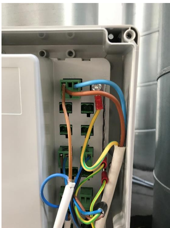
Figur 6.13 Strømforsyningsboks til ventilationsanlæg
