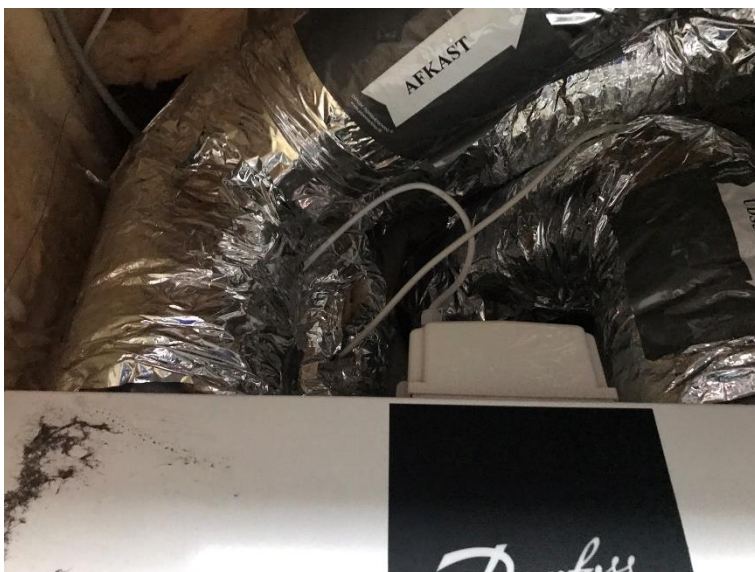
Figur 7.8. Decentralt ventilationsanlæg til etagebolig
