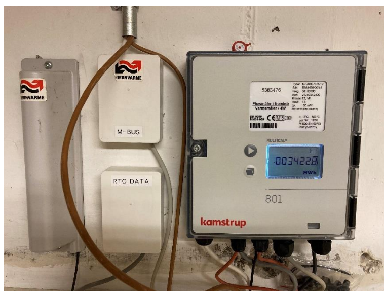
Figur 7.6 Vekslerens ydelse/effekt kan aflæses på varmemåleren, der desuden måler flow samt fremløbs- og returtemperatur
