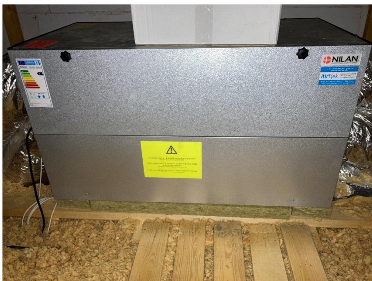
Figur 6.6. Ventilationsanlæg i enfamilieshus
