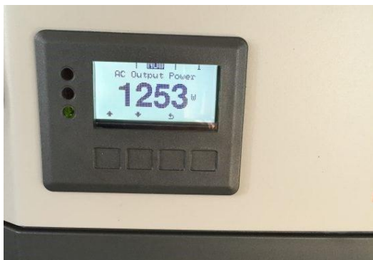
Figur 6.23. Effektmåling på inverter-niveau
