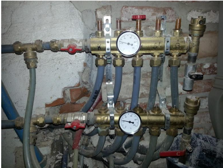
Figur 6.1 Termometre på gulvvarmeanlæg
