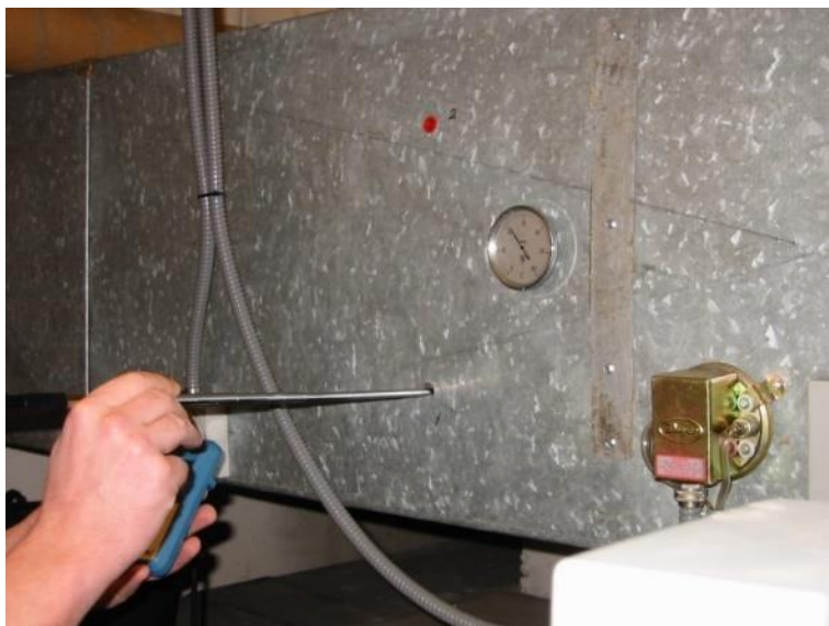
Figur 7.10 Måling i rektangulær kanal
