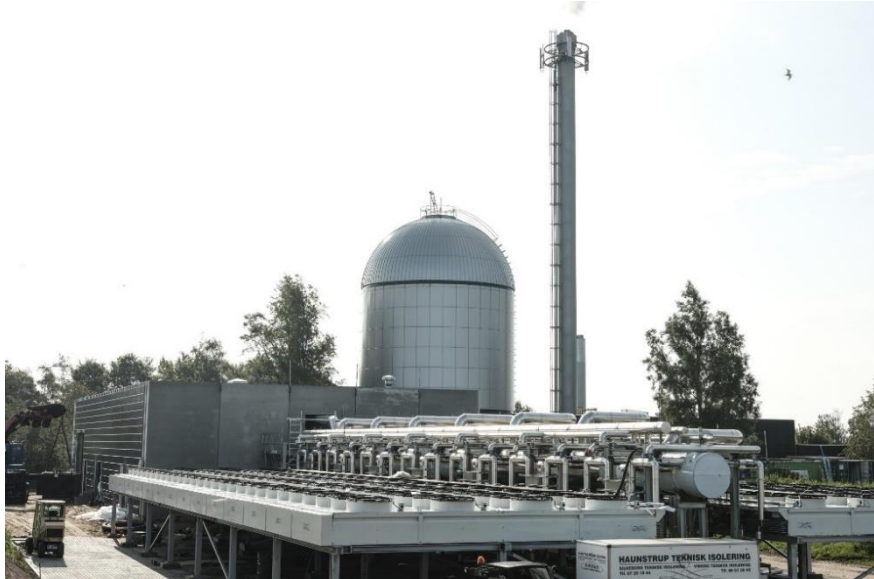
Foto: Støvring Kraftvarmeværk, 7 MW varme , 2020
