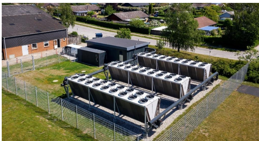
Foto: Slagslunde Fjernvarme, 1 MW varme , 2020
