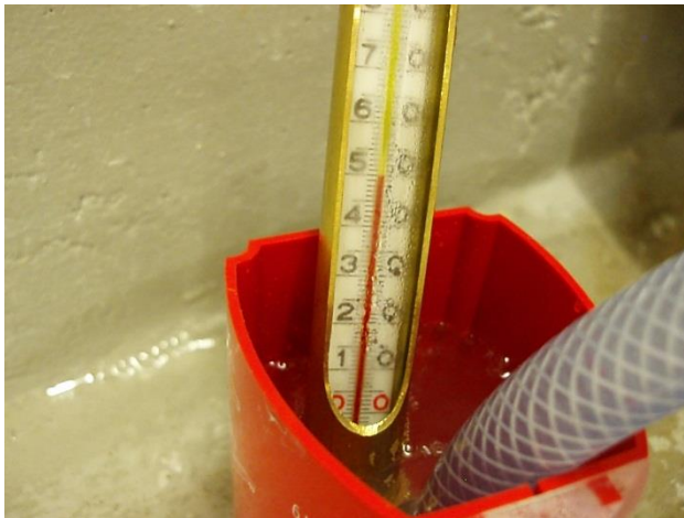
Billede fra testkørsel, hvor temperaturen var næsten 50 °C, selvom reguleringsventilen var skruet helt i bund.
