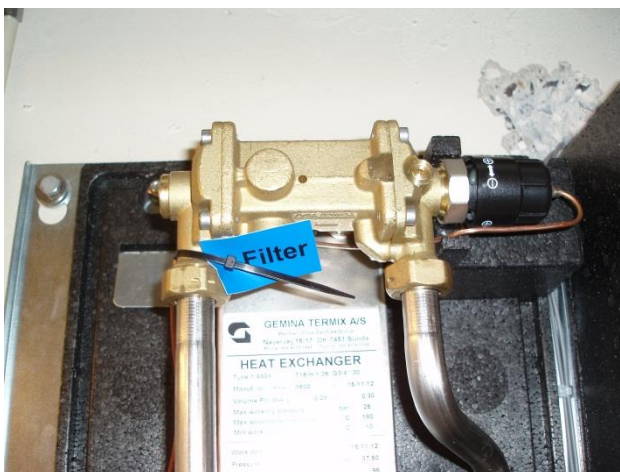
Reguleringsventil skruet helt i bund uden at temperaturen kommer ned på 45 °C.
