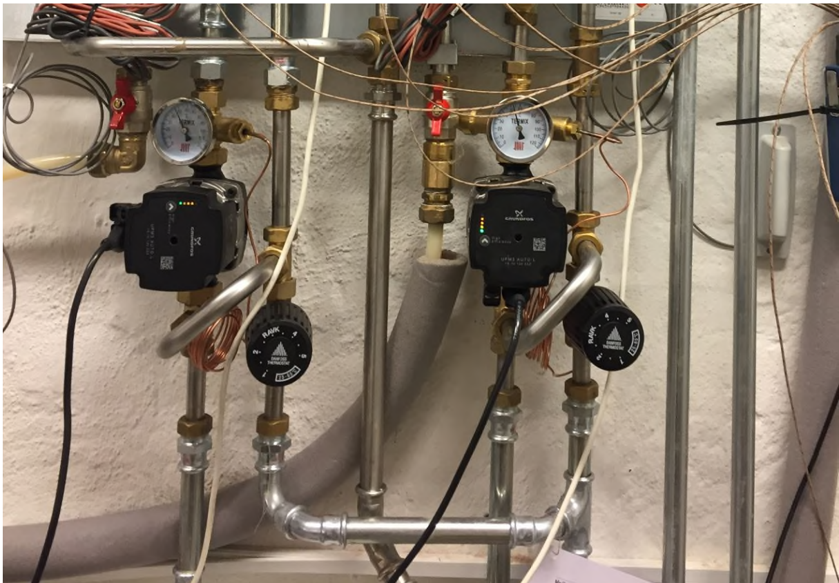
Billede af et af shuntarrangementerne med pumper og reguleringsventiler.
