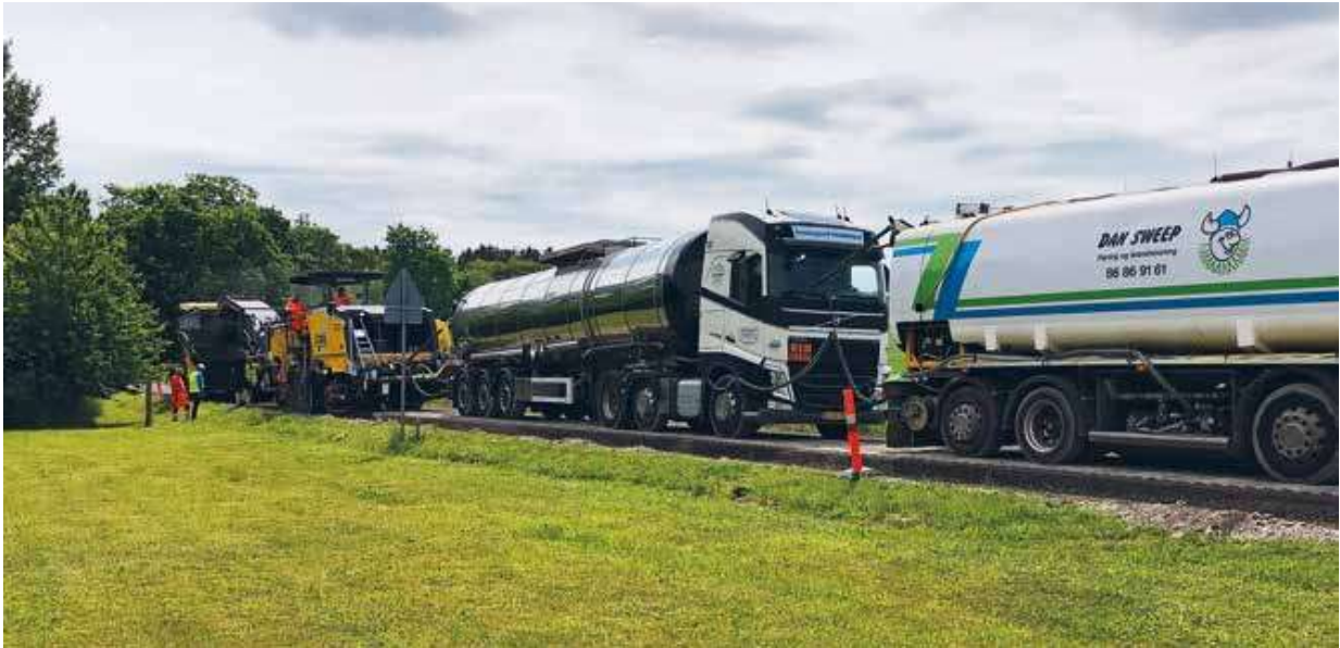
BSM fremstillet ved in-situ metoden, direkte på vejen med en speciel fræse-/blandemaskine, bagvedkørende asfaltudlægger samt forankørende tankbiler.
