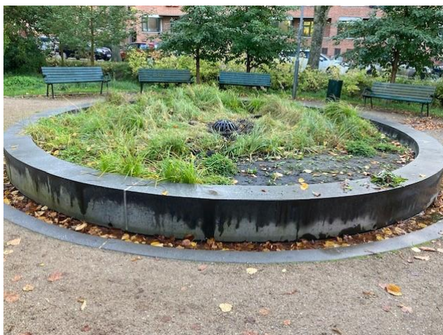
Figur 4: Kilden. Regnvandet pumpes ind gennem risten øverst i Kilden og derefter siver regnvandet gennem jordfiltret og ud i renden omkring Kilden
