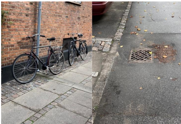
Figur 2: Tagvand ledes ud på vejoverflader og gennem skybrudsriste til en separat regnvandsledning.
