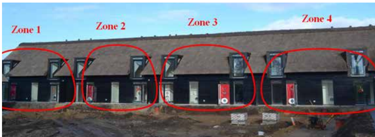
Figur 6.7 – Her er bygningen udført med 4-zonetest, hvilket er i henhold til standarden.
