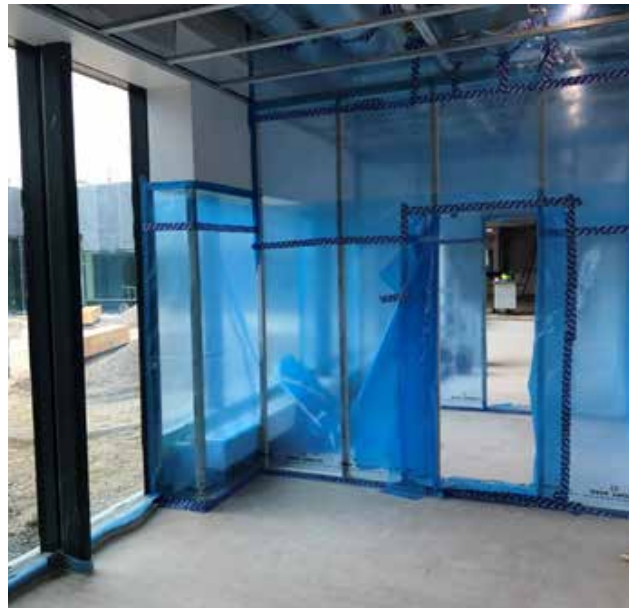
Figur 6.5 – Test af klimaskærmssektion.
