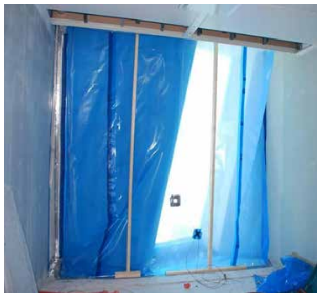
Figur 8.6 – Membran opsat foran en facade klar til måling.
